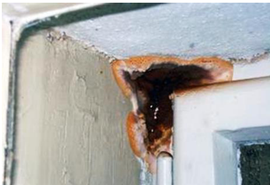
Obr. 4 Napadení omítky houbami
