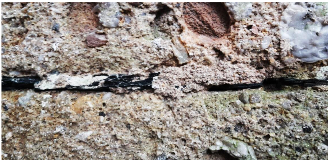
Obr. 10 Břidlice jako hydroizolace v ložné spáře ve zdivu
