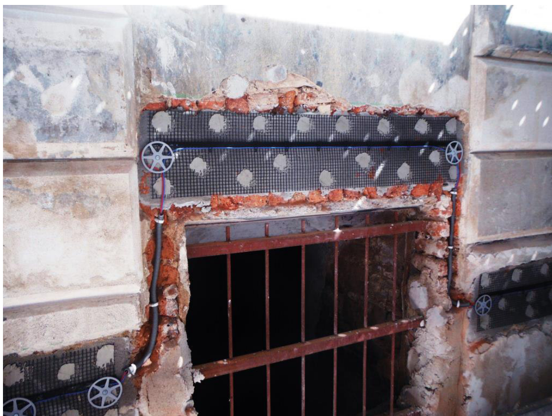
Obr. 12 Umístění grafitové mřížkové elektrody na zdivo - metoda aktivní elektroosmózy
