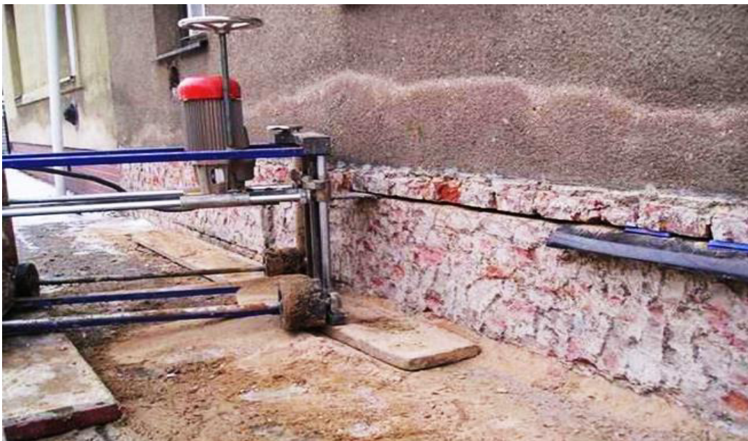
Obr. 9 Prořezávání spáry ve zdivu
