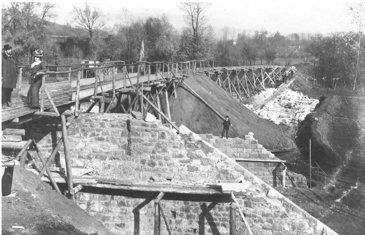
Obrázek 2 Stavba železniční trati v roce 1902
