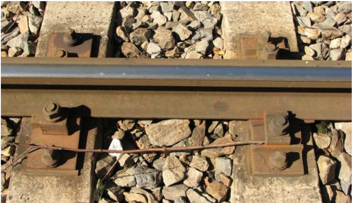
Obrázek 17 Rozdíl v konstrukci upevnění s žebrovou podkladnicí (vlevo) a s rozponovou pokladnicí Zdroj: Běžná kolej (2. část). SŽDC. [online]. © 2009-2012 [cit. 2016-12-12]. Dostupné z: http://www.szdc.cz/onas/zeleznice-cr/historie-zeleznice/zeleznicni-svrsek/bezna-kolej-2.html
