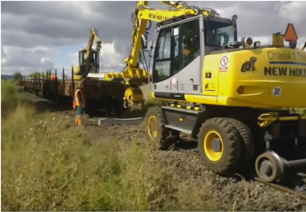
Obrázek 16 Dvoucestné rypadlo provádějící výměnu pražců
