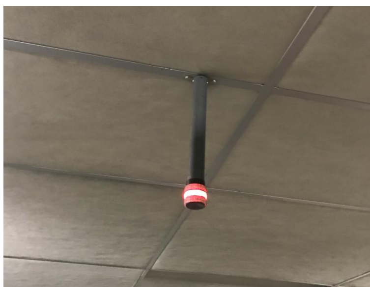
Obrázek 26 – Parkovací systém – ukazatel obsazenosti stání
