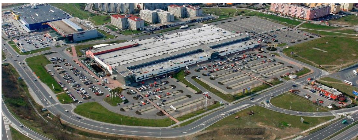
Obrázek 9 – Pohled shora na centrum před rekonstrukcí
