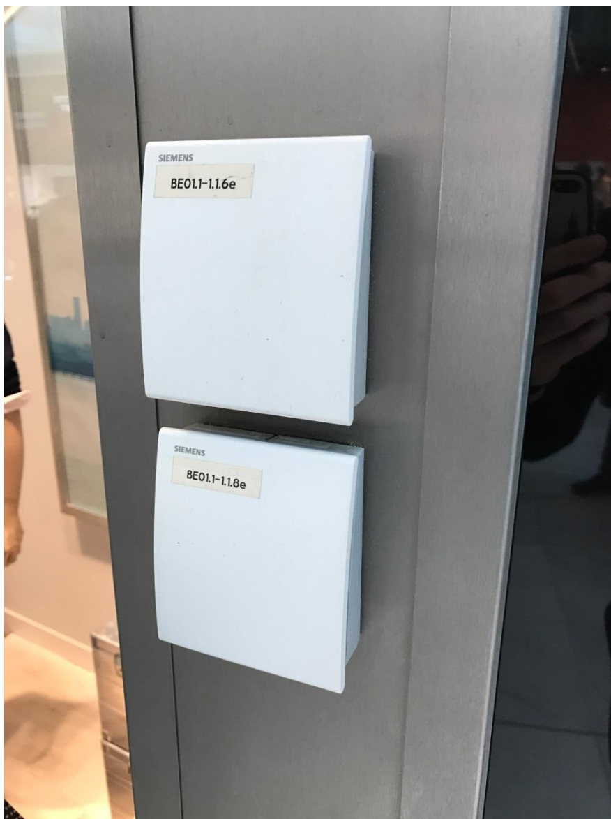
Obrázek 28 – Čidla na teplotu a kvalitu vzduchu v pasáži
