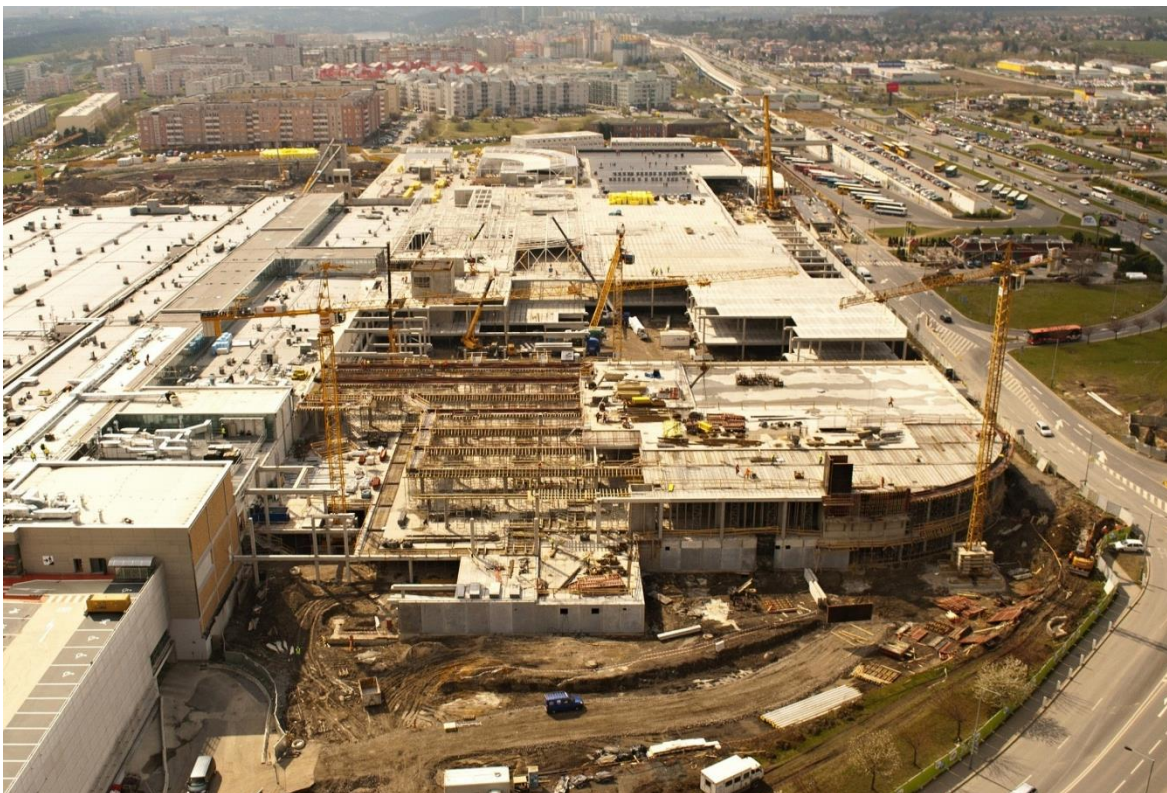
Obrázek 11 – Průběh rekonstrukce a rozšíření centra
