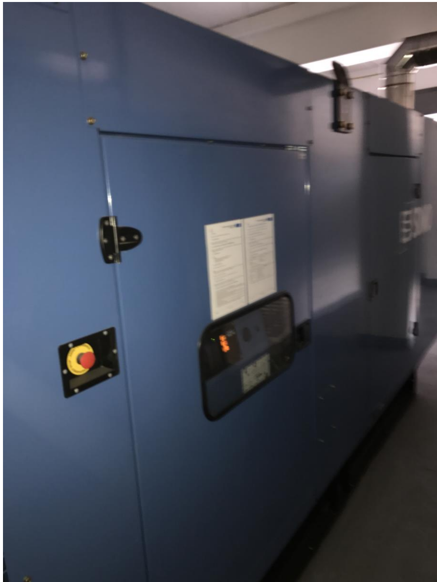
Obrázek 24 – Dieselagregát
