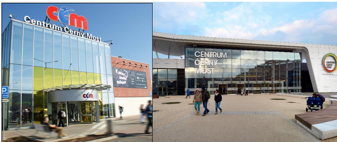
Obrázek 14 – Rozdíl vstupů před a po rekonstrukci
