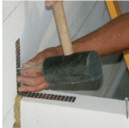
Obr. 22: Kotvení spojky zdiva hřebíkem [14]
