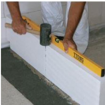
Obr. 21: Kontrola rovinnosti, urovňání [14]
