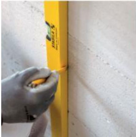
Obr. 19: Vyznačení budoucí polohy příčky, [14]
