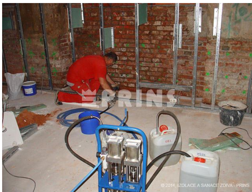
Obr. 2: Souprava pro tlakovou injektáž zdiva, převzato z [2]
