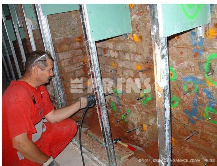
Obr. 3: Tlaková injektáž zdiva přes injektor, převzato z [2]
