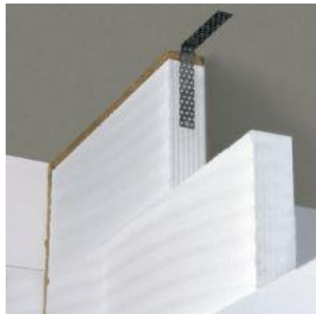
Obr. 24: Kotvení a dilatace u stropu [14]
