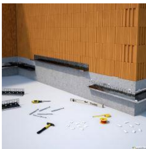
Obr. 28: Vložení mezilehlých základacích lišt [19]
