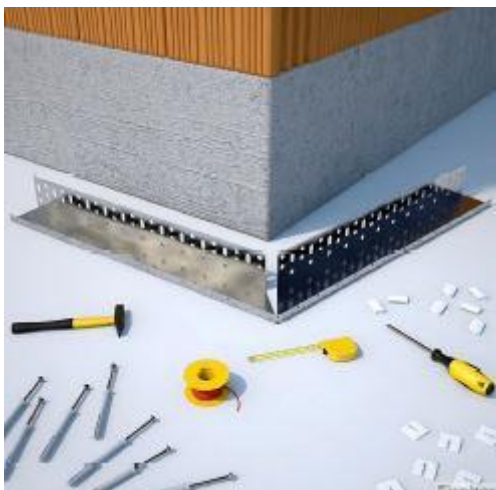
Obr. 25: Příprava základací lišty pro roh objektu [19]
