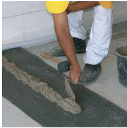
Obr. 20: Základní vrstva tepelně-izolační malty [14]
