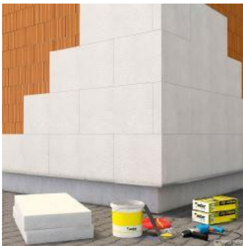
Obr. 31: Spáry v nároží objektu [19]
