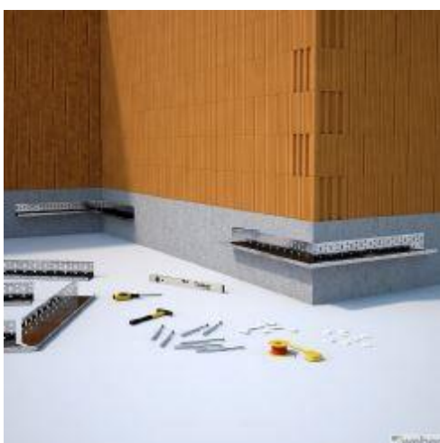
Obr. 27: Ukotvení základací lišty v rozích objektu [19]
