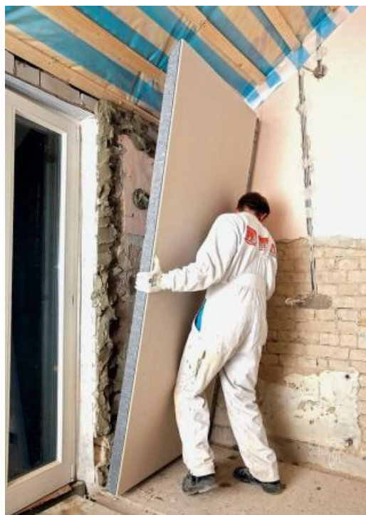
Obr. 3 – Aplikace systému Rigips – Rigitherm [7]
