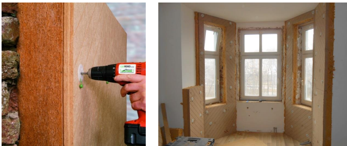
Obr. 8 – Aplikace systému UdiIN RECO [13]
