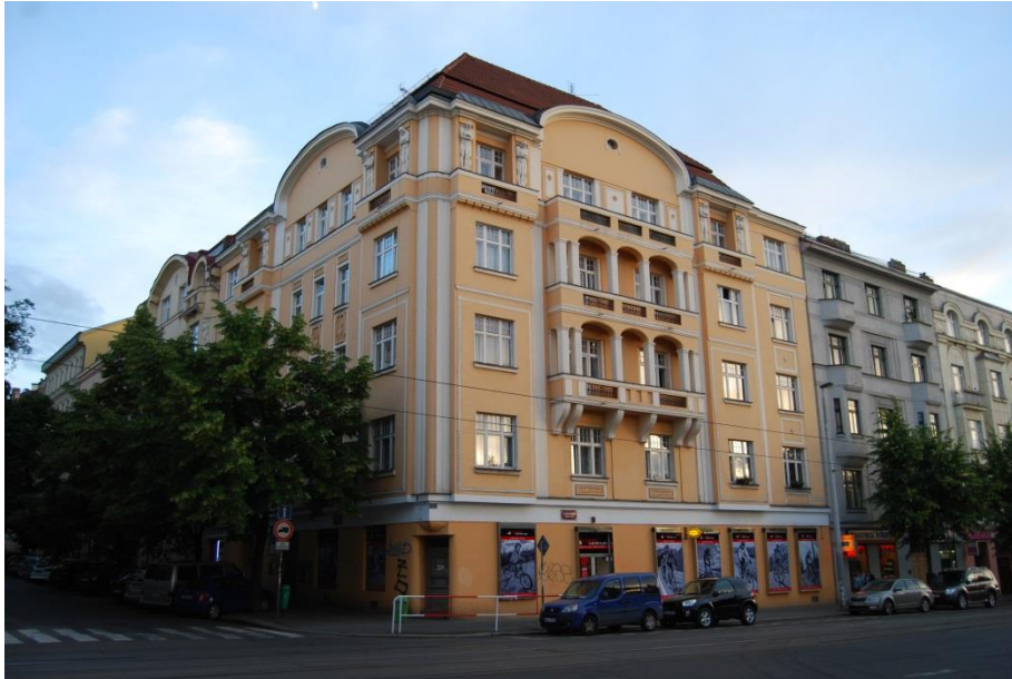
Obr. 11 – Pohled na objekt
