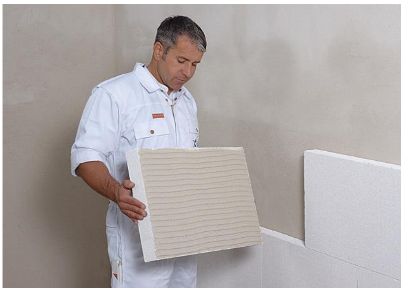
Obr. 5 – Aplikace systému Ytong – Multipor [9]
