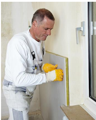
Obr. 9 – Aplikace systému Aerorock [14]
