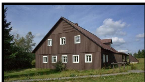
Obr. 2-4 Pohled na objekt 4
