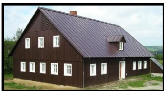
Obr. 2-1 Pohled na objekt 1
