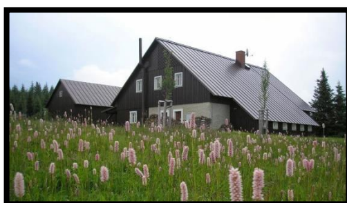
Obr. 2-2 Pohled na objekt 2
