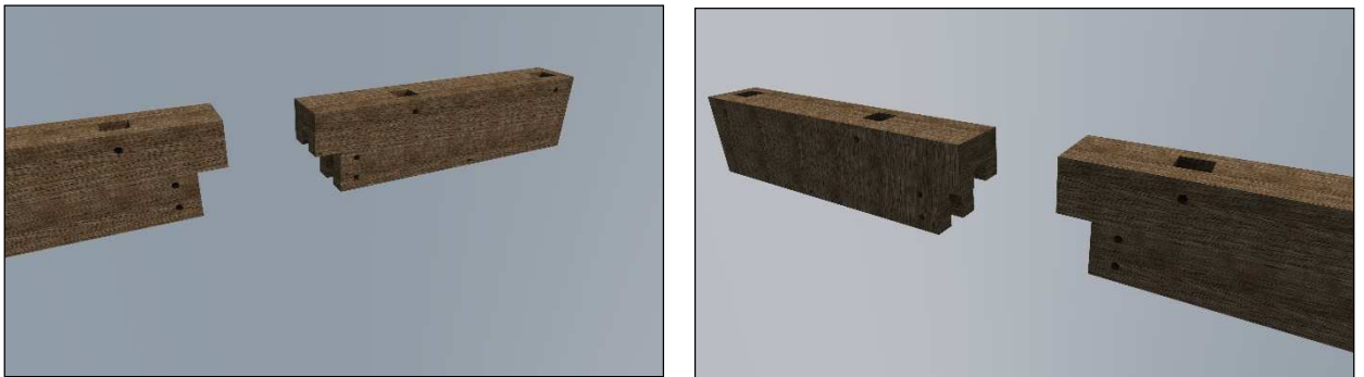
Obr. 29 Středové nosné trámy 1-2.NP
