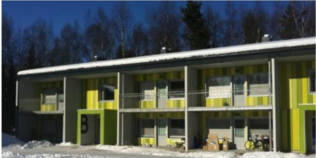
Obrázek 41: Rekonstrukce bytového domu z roku 1985 v Oulu, Finsku (NeZer). Po zateplení obálky a vyregulování otopné soustavy byla nově roční potřeba tepla na vytápění 40 \text{ kWh/m}^2 (před realizací 91 \text{ kWh/m}^2 ) [26].
