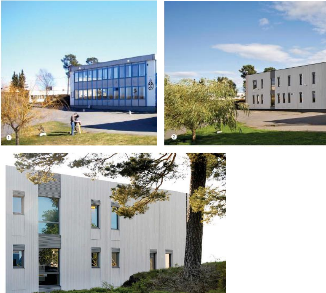
Obrázek 33: Risor Technical College, Norsko, stav před (vlevo) a po realizaci (vpravo a dole). Instalací prefabrikovaných panelů a zateplením střechy byla snížena potřeba tepla na vytápění z původních 325 kWh/m 2 na 49 kWh/m 2 (Renew School) [21]
