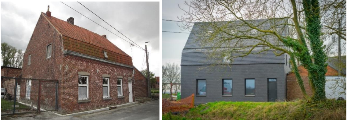
Obrázek 36: Renovace rodinného domu z roku 1901 v rámci projektu Refurb v Spiere, Belgii. Bylo provedeno zateplení obvodových stěn, střechy a výměna otvorových výplní. Nově bylo nainstalováno nucené větrání s rekuperací a zaregulována otopná soustava. [22]
