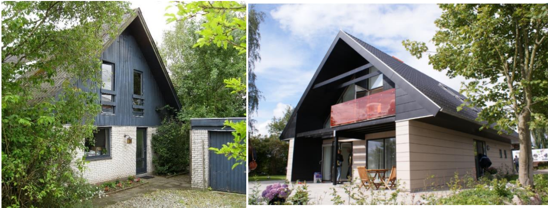
Obrázek 35: Původní stav a stav po realizaci opatření na rodinném domě v Dánsku. Byla dosažena úspora spotřeby energie okolo 68 % (Refurb). [22]
