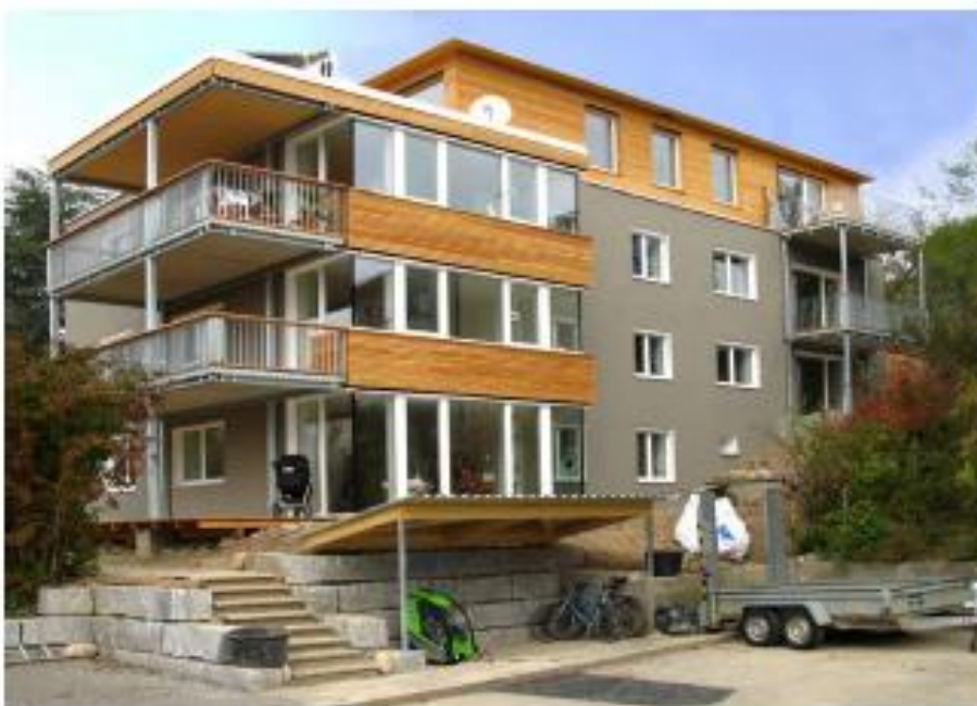
Obrázek 23: Bytový dům po rekonstrukci. Došlo k rozšíření vytápěné plochy a zateplení obálky pomocí dřevěných prefabrikovaných panelů s integrovaným vzduchotechnickým potrubím. Jako zdroj tepla bylo instalováno tepelné čerpadlo země-voda. Na střechu bylo instalováno 12,5m 2 solárních kolektorů a fotovoltaické panely o výkonu 16,1 kWp. Úspora na vytápění je 88,6 % na m 2 [9].
