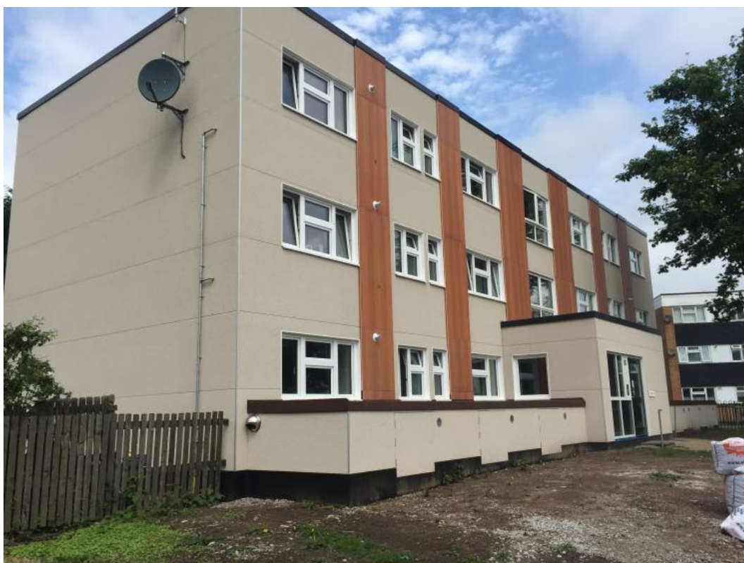
Obrázek 40: Dokončená realizace. Projekt OWLS se více než na vývoj jednoho systému fungující pro největší počet budov soustředil na zjednodušení procesu realizace za účelem minimalizace nákladů a s důrazem na kvalitu. Plánuje se, že projekt by se mohl opakovat ve větším měřítku na typologicky podobných budovách [34].
