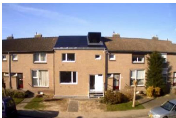
Obrázek 31: Rekonstrukce řadového domu na energeticky nulový standard ve městě Heerlen, Holandsko. Vlevo stav před realizací, vpravo dokončený objekt [17].
