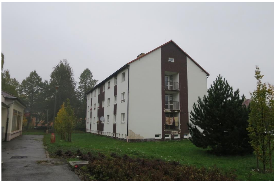
Obrázek 51: Severní štítová fasáda s lodžemi
