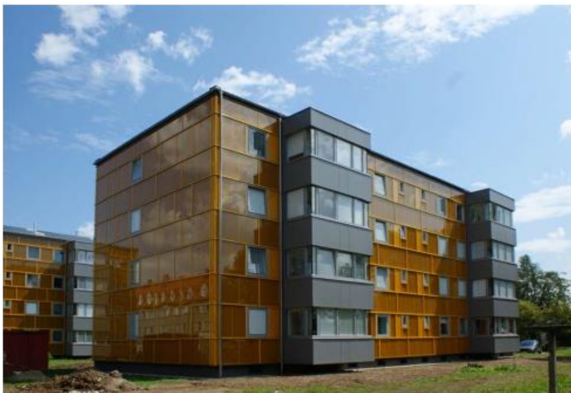
Obrázek 25: Bytový dům v Grazu po rekonstrukci. Obvodové konstrukce byly zatepleny pomocí solárních fasádních panelů s integrovaným vzduchotechnickým potrubím. Původní balkony byly zahrnuty do vytápěné plochy, čímž byly eliminovány tepelné mosty a zvětšen obytný prostor. Nově byl také přistavěn výtah. Jako zdroj tepla je využíváno tepelné čerpadlo země-voda, napojené na nově vybudovanou otopnou soustavu. Rozvody otopné vody jsou vedeny pod prefabrikovanými panely. Pro ohřev teplé vody byly instalovány solární kolektory (3 m 2 ). Úspora na potřebě tepla na vytápění je okolo 93 % (po realizaci je hodnota měrné potřeby tepla 12 kWh/m 2 za rok) [9]
