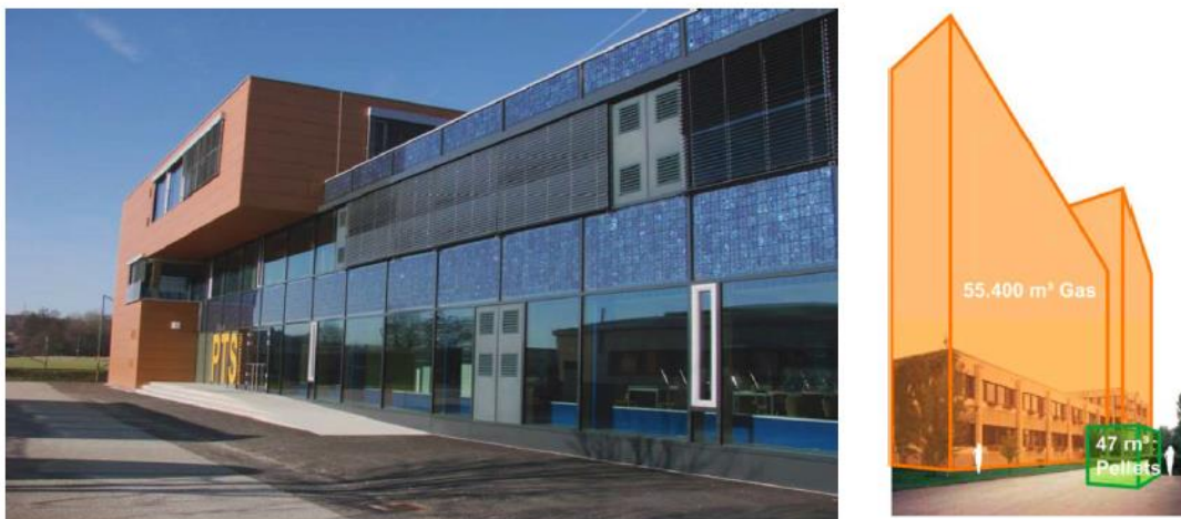
Obrázek 34: Rekonstrukce školy ze sedmdesátých let v Schwanenstadt, Rakousku v rámci projektu Renew School. Zateplení obálky bylo provedení pomocí prefabrikovaných panelů. Novým zdrojem tepla je kotel na pelety, dále bylo instalováno nucené větrání s rekuperací a fotovoltaické panely. Potřeba tepla na vytápění byla snížena o 90 %. Na obrázku vpravo grafická prezentace spotřeby plynu v původním stavu (oranžová barva) a pelet po realizaci (zelená barva). [21]
