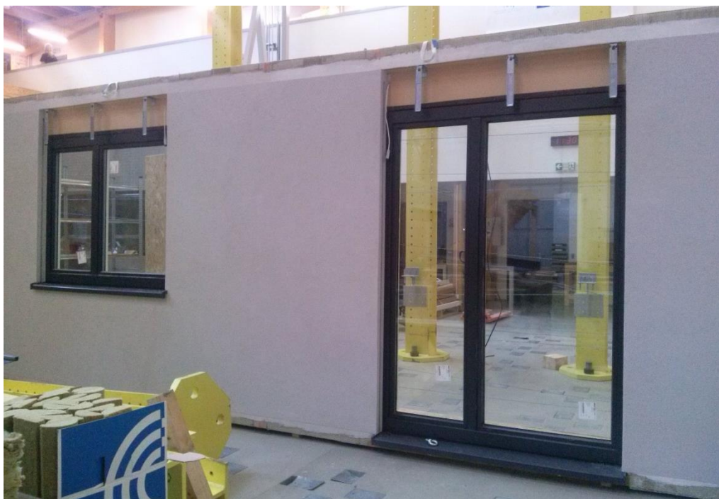
Obrázek 60: Prototyp panelu MORE-CONNECT včetně otvorových výplní. Chybí pouze zabudování vnějších lamelových žaluzií [36].
