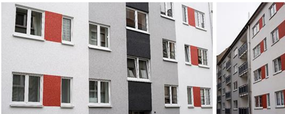
Obrázek 30: Nová fasáda po realizaci projektu RetroKit [13].
