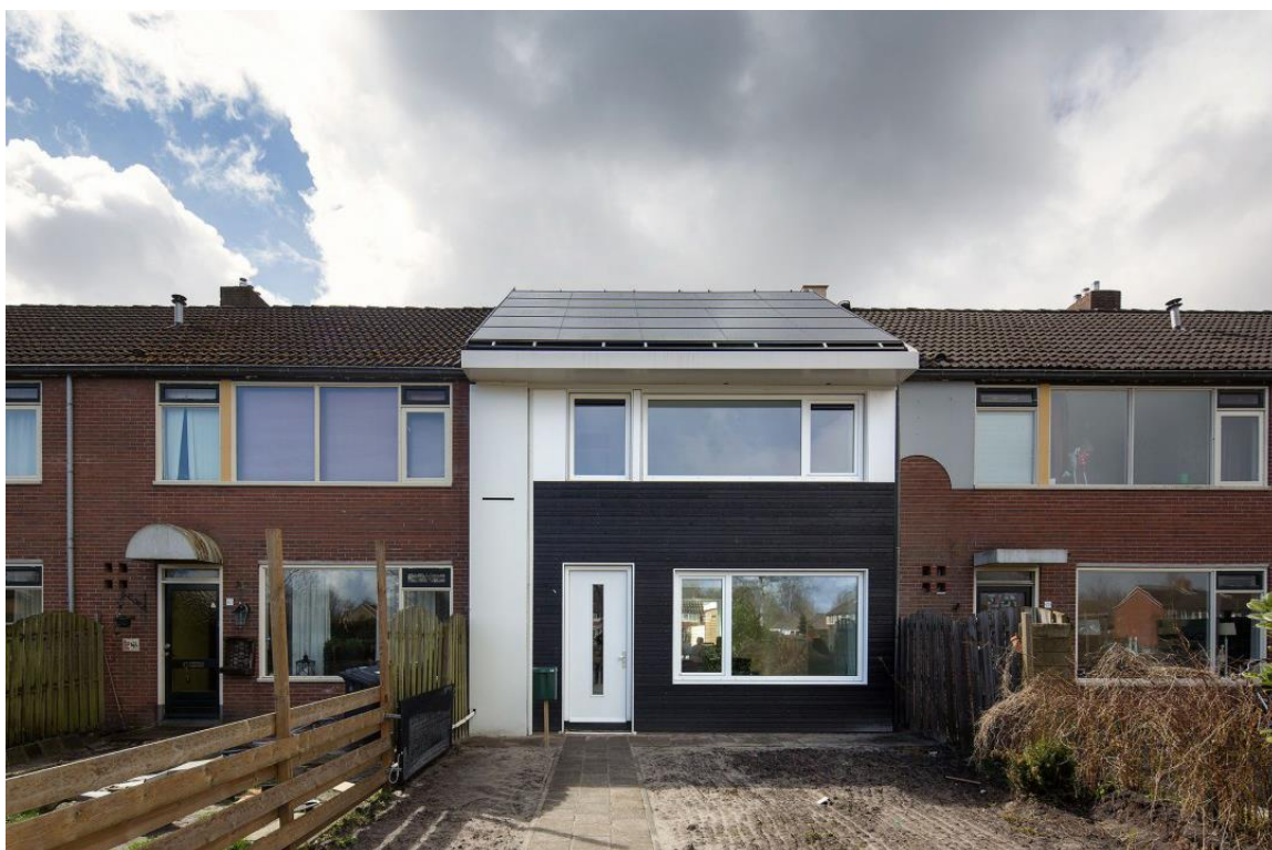
Obrázek 32: Realizace projektu Transition Zero v Nieuw Buinen, Holandsko. Instalace fasádních panelů trvala pouhý jeden den oproti první realizaci, která trvala dva týdny. Bylo zde zavedeno nucené větrání s rekuperací, instalovány solární panely na střeche a jako zdroj tepla slouží tepelné čerpadlo [33].
