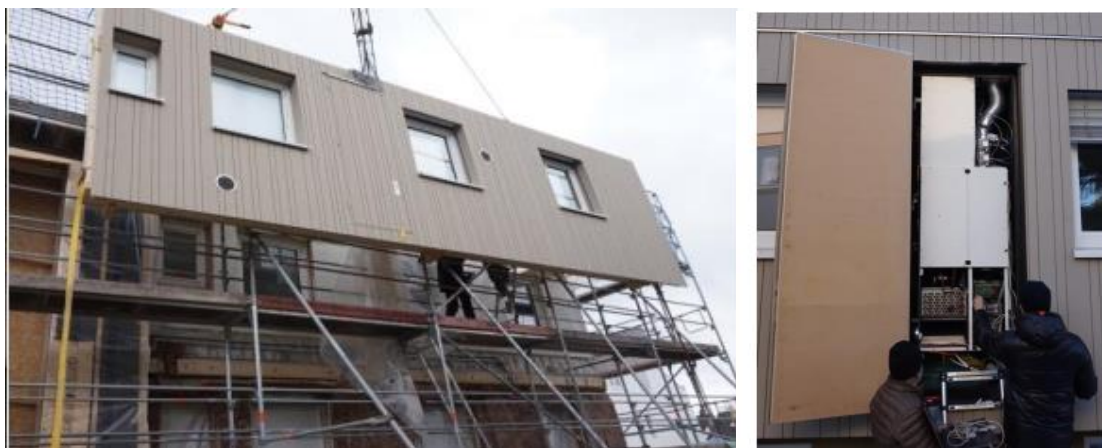
Obrázek 45: Instalace dokončeného prefabrikovaného panelu (vlevo). Vzduchotechnická jednotka integrovaná do obvodového pláště (vpravo) [31].
