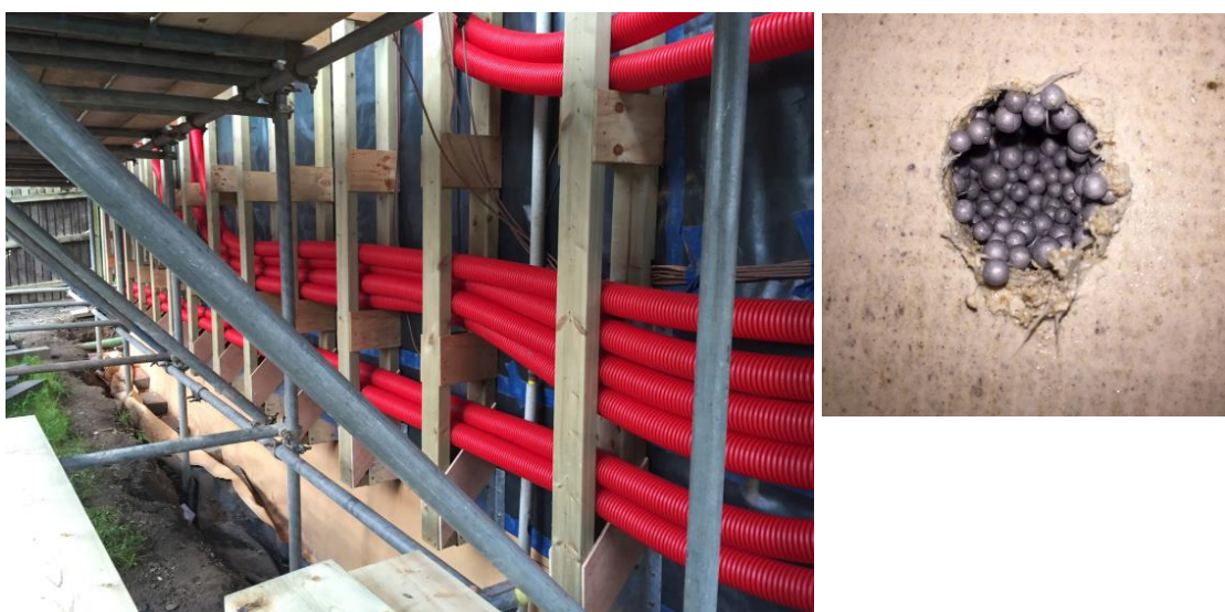
Obrázek 38: Budova je obalena parotěsnou folií pro zajištění vzduchotěsnosti. Mezi dřevěnými prvky vede vzduchotechnické potrubí. V dalším kroku je se konstrukce zaklopí protipožární deskou a do dutiny se nafouká tepelná izolace (foto vpravo). Jako poslední pak přijde další vrstva tepelně-izolačních desek [34].
