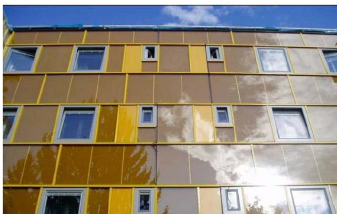
Obrázek 2: Pohled na fasádu. Povrch celulózevové struktury může být natřen různými barvami pro dosažení požadovaného vzhledu [9].
