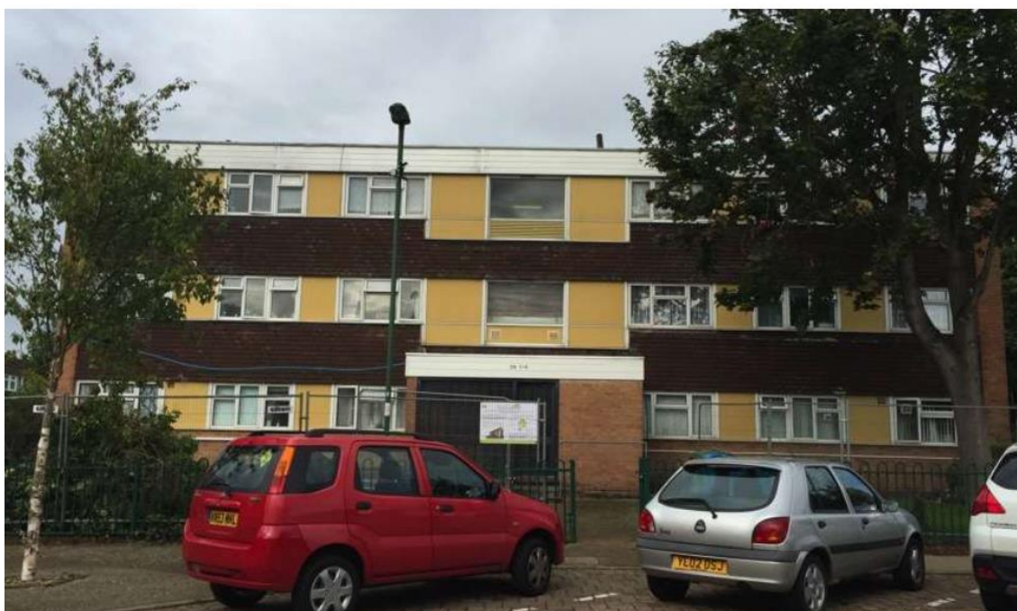
Obrázek 37: Renovace v rámci projektu OWLS pomocí patentovaného systému TCosy v Solihull, Anglii. Stav před rekonstrukcí [34].
