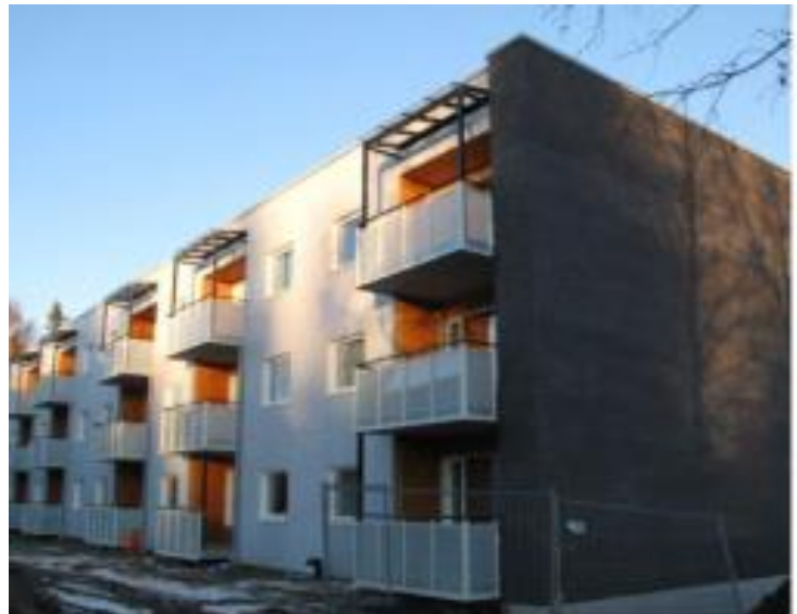
Obrázek 42: Rekonstrukce bytového domu ze šedesátých let v Skedsmokorset, Norsku (NeZer). Kromě zateplení obálky bylo zavedeno nucené větrání s rekuperací a instalovány vakuové kolektory pro ohřev teplé vody [28].
