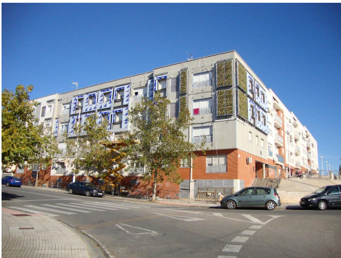
Obrázek 27: Realizace proběhla v září 2016. Celkem sedm typů prefabrikovaných modulů lišících se vlastnostmi (zelený, izolační, provětrávaná fasáda, BIPV, panely s integrovanými technologickými jednotkami, ...) bylo sestaveno v blízké dílně a úspěšně instalováno na fasádu [10].
