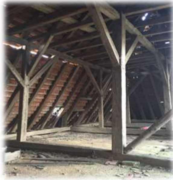
Obrázek 12 - Krov jižní části zámku
