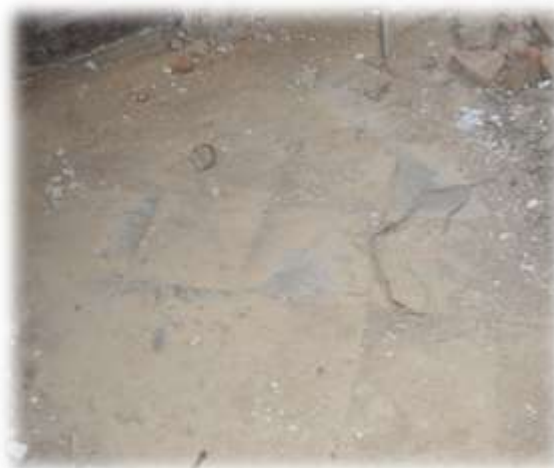
Obrázek 24 - Betonové dlaždice v chodbě 1.12
