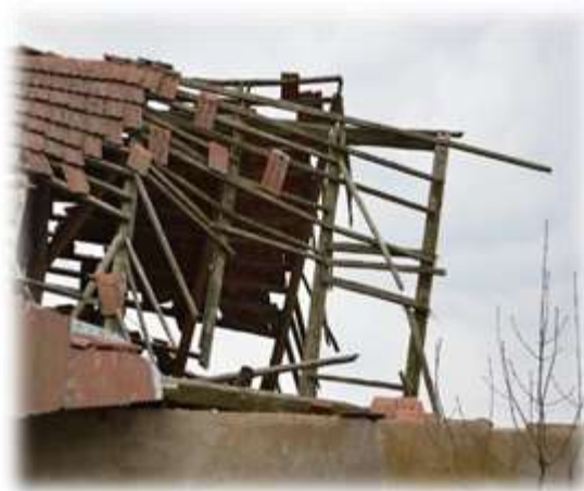
Obrázek 14 - Střešní konstrukce hospodářského sídla
