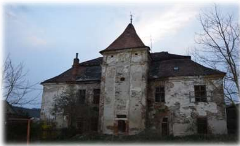
Obrázek 2 – Východní průčelí zámku Petrovice u Miličina
