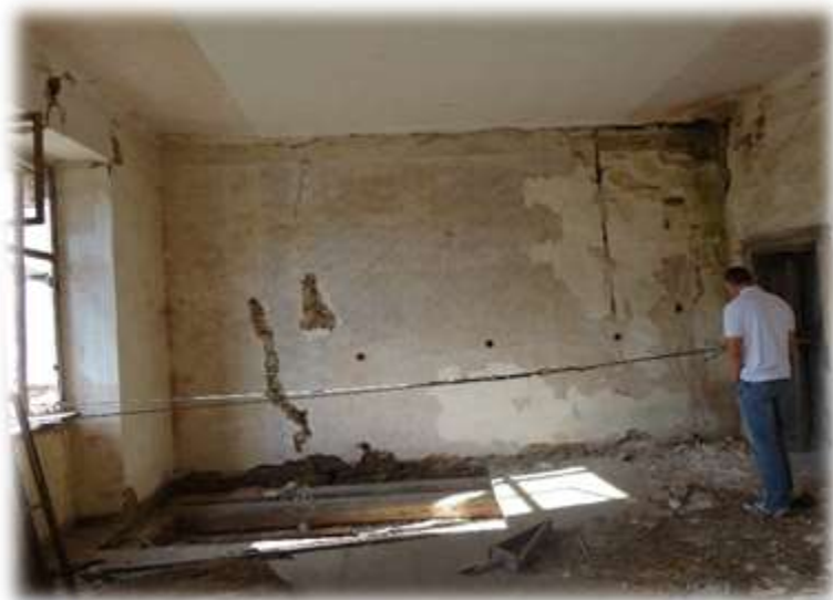
Obrázek 5 – Ocelové spínací lano v místnosti 2.14
