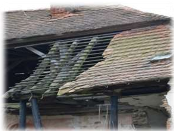
Obrázek 13 – Mansardová střecha zámku
