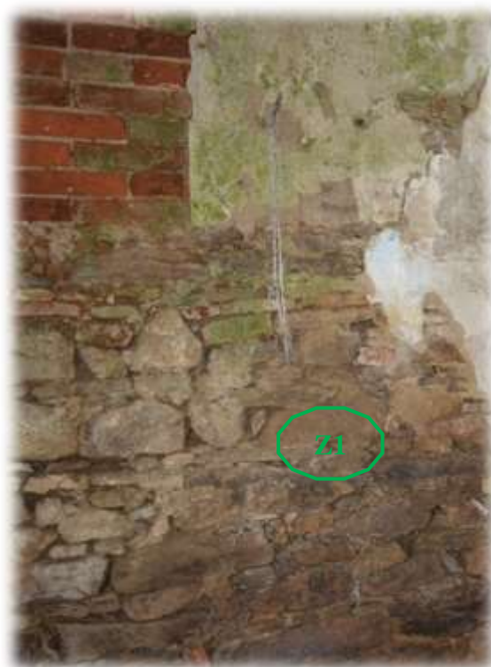
Obrázek 33 - Plíseň a opadaná omítka v místnosti 1.05
