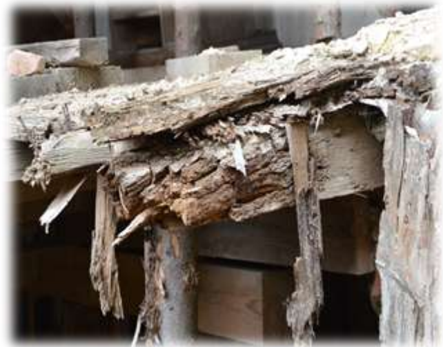
Obrázek 68 – Dřevěný trám napaden koniforou sklepní Obrázek 69 - Napadení trámu dřevokazným hmyzem
