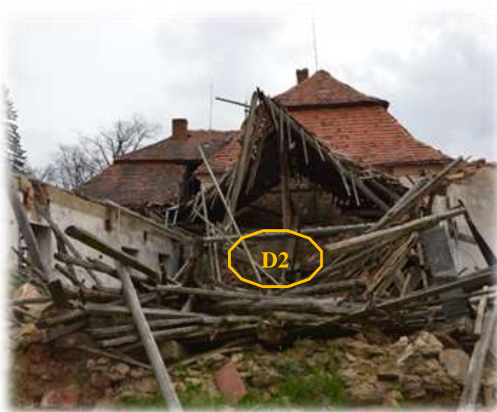
Obrázek 42 – Průhyb krokví nad východní částí zámku Obrázek 43 - Zřícenina hospodářské západní části objekt
