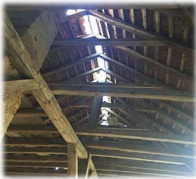
Obrázek 11 - Střešní konstrukce severního vnitřního průčelí
