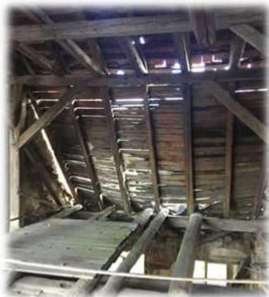
Obrázek 42 – Průhyb krokví nad východní částí zámku Obrázek 43 - Zřícenina hospodářské západní části objekt
