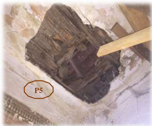
Obrázek 53 - Porucha stropní konstrukce v místnosti 2.02 Obrázek 54 – Propad P3 klenby v místnosti 1.07
