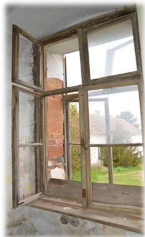
Obrázek 22 - Šestitabulkové okno
