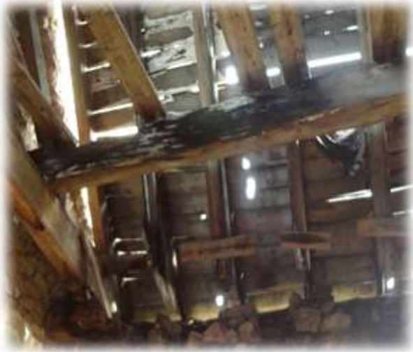
Obrázek 68 – Dřevěný trám napaden koniforou sklepní Obrázek 69 - Napadení trámu dřevokazným hmyzem
