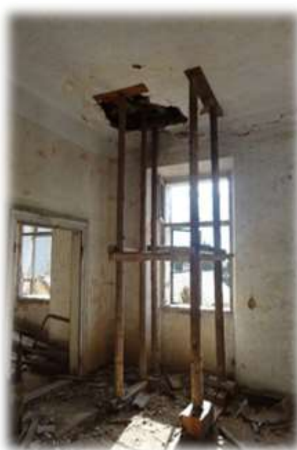
Obrázek 10 – Podpěry v místě otvoru 2.10
