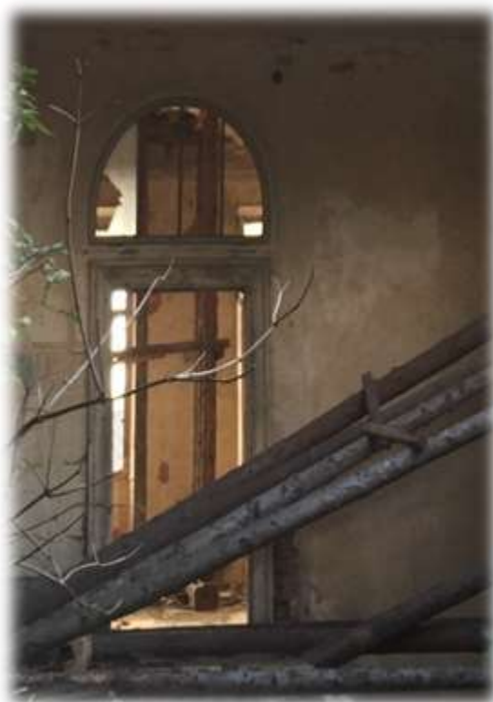
Obrázek 20 - Jednokřídlé dveře s obloukovým nadsvětlíkem v chodbě 2.11
