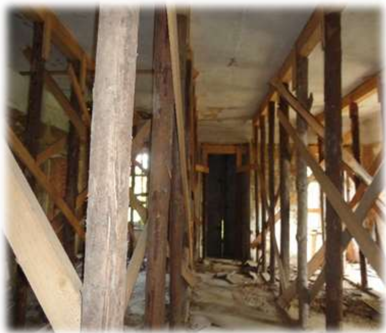
Obrázek 9 - Podpěry stropní konstrukce v místnosti 2.02
