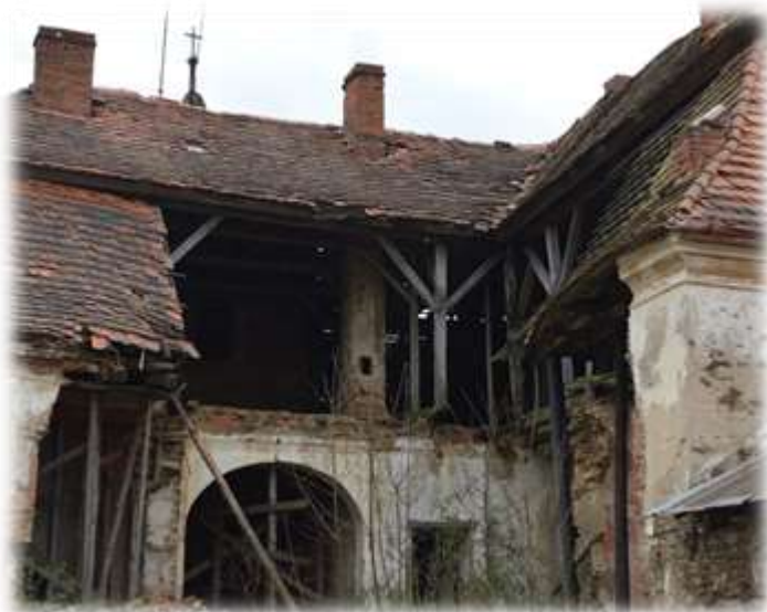
Obrázek 40 - Zřícení střešní konstrukce ve vnitřním průčelí zámku Obrázek 41 - Sloupek na uhnilém vazném trámu
