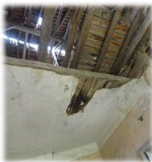
Obrázek 8 - Dřevěný trámový strop
