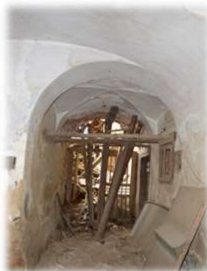
Obrázek 6 - dřevěné rozpěry v chodbě 1.13
