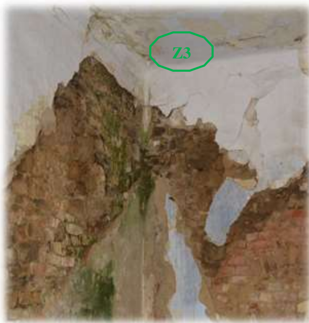
Obrázek 50 - Plíseň a opadaná omítka v místnosti 1.17
