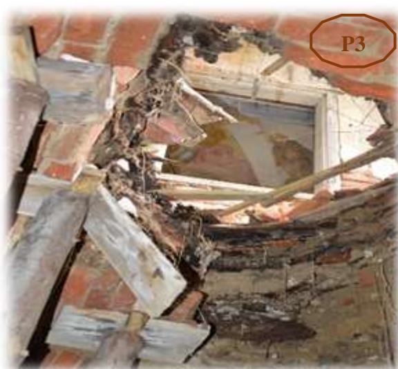
Obrázek 53 - Porucha stropní konstrukce v místnosti 2.02 Obrázek 54 – Propad P3 klenby v místnosti 1.07
