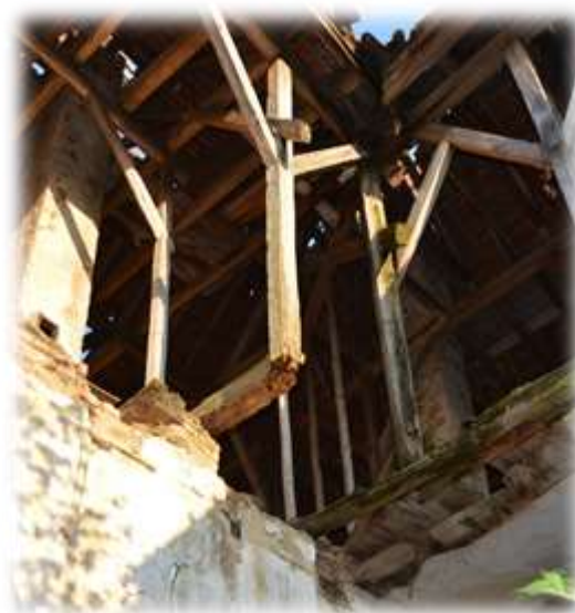
Obrázek 40 - Zřícení střešní konstrukce ve vnitřním průčelí zámku Obrázek 41 - Sloupek na uhnilém vazném trámu
