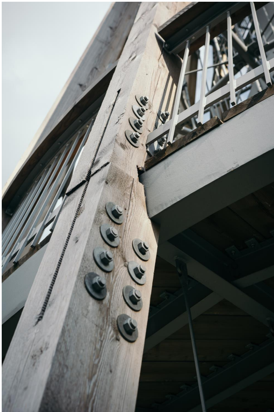
Obrázek 47 – Fotografie – detail B – napojení nárožníků
