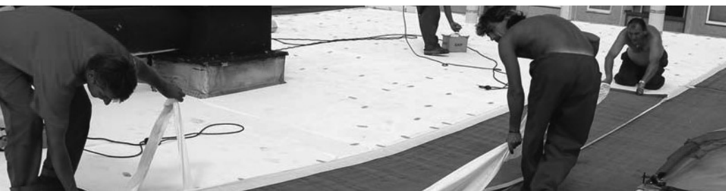
02| skladba dvouplášťové střechy s pojistnou hydroizolací
