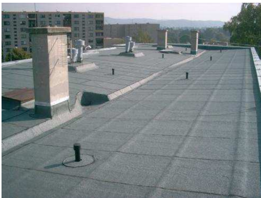
Obr. 1 – Plochá střecha s klasickým pořadím vrstev 2
