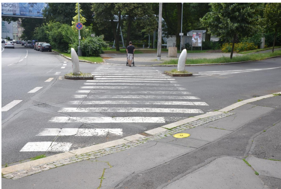
Obrázek 32 Současný stav přechodu v ulici Šaldova zdroj: autor
