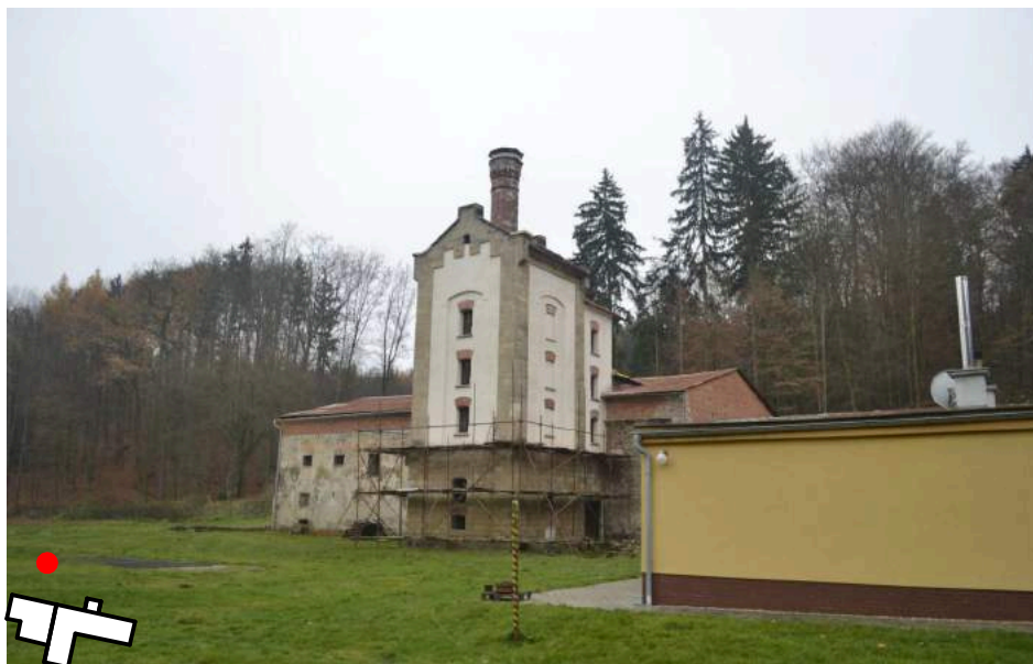
pohled ze severozápadu na areál bývalého pivovaru (11/2016)
