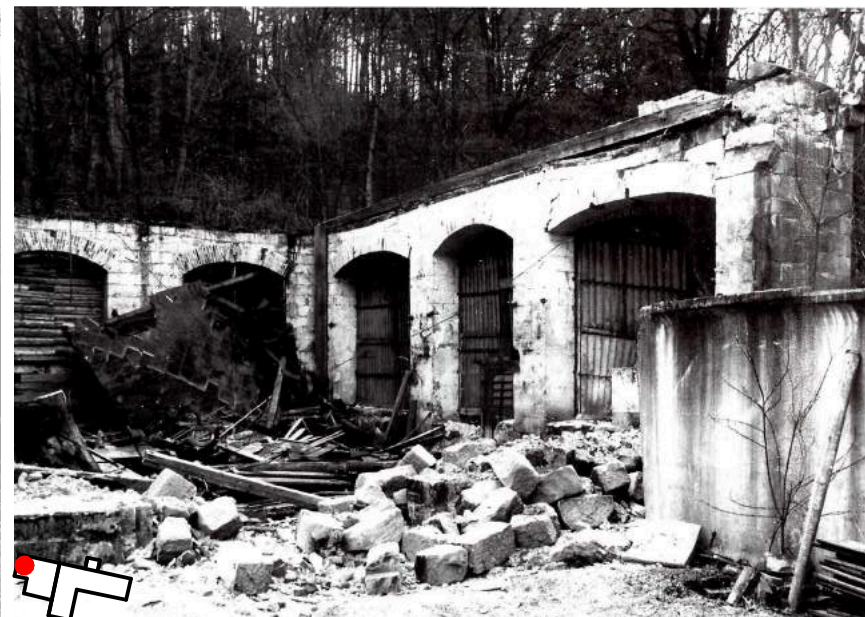
fotografie bývalé budovy, kde byly chladící štoky (asi kolem 1996)
