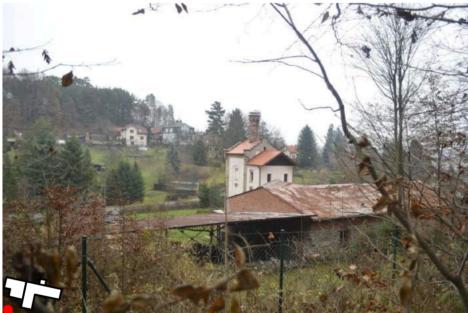
pohled z jihozápadu na areál bývalého pivovaru (11/2016)
