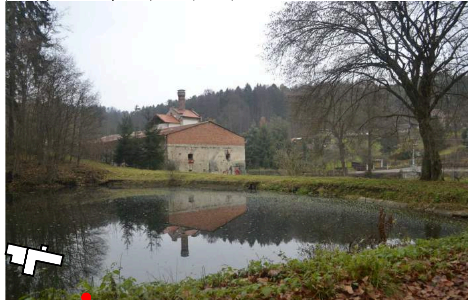
pohled z jihovýchodu na areál bývalého pivovaru (11/2016)
