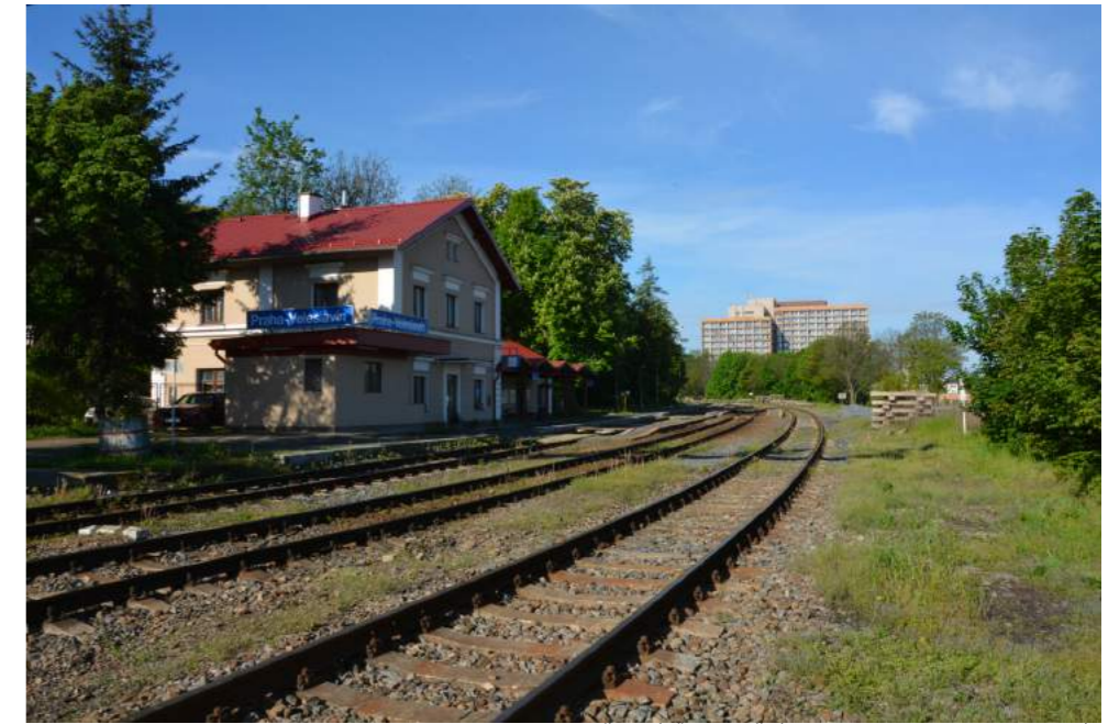
Současná železniční stanice Praha - Veveřavín
