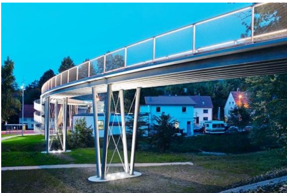
Obr. 10 - Lávka pro pěší ve městě Albstadt [26]
