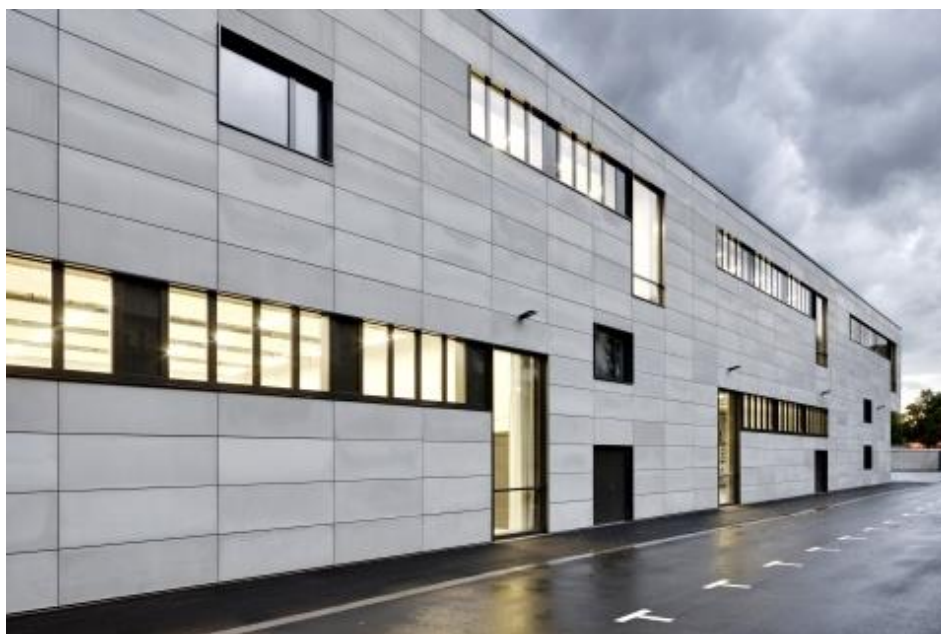
Obr. 11 - Budova Ballet am Rhein v Dusseldorfu s fasádními panely z textilního betonu [27]
