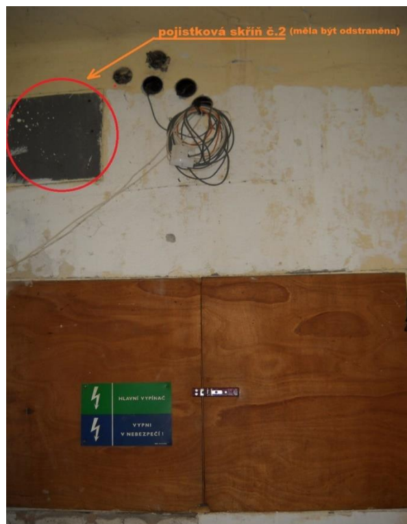
Obr. 11 Neodstraněná PS v neodstraněné pojistkové skříni v uzamčené chodbě RD
