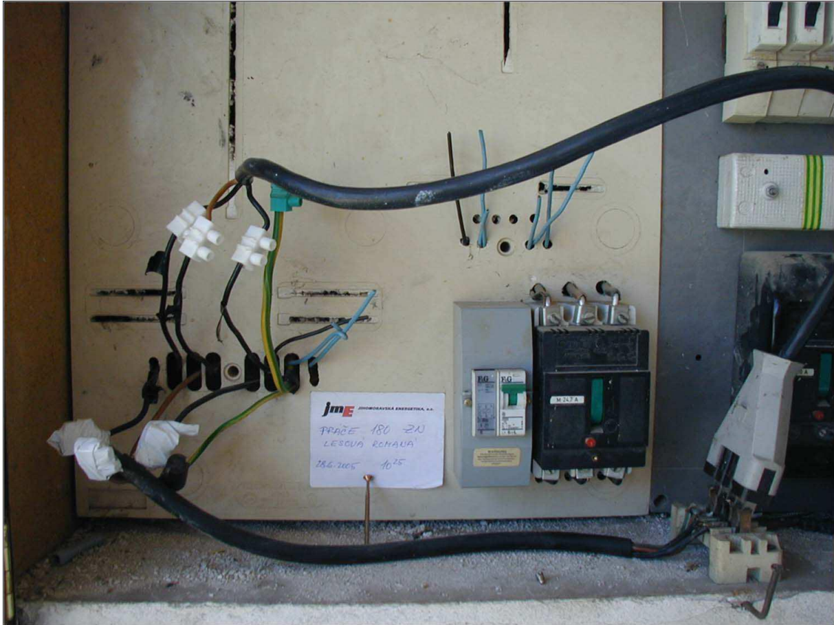
Obr. 21 Napojení odběru elektrické energie bez měření
