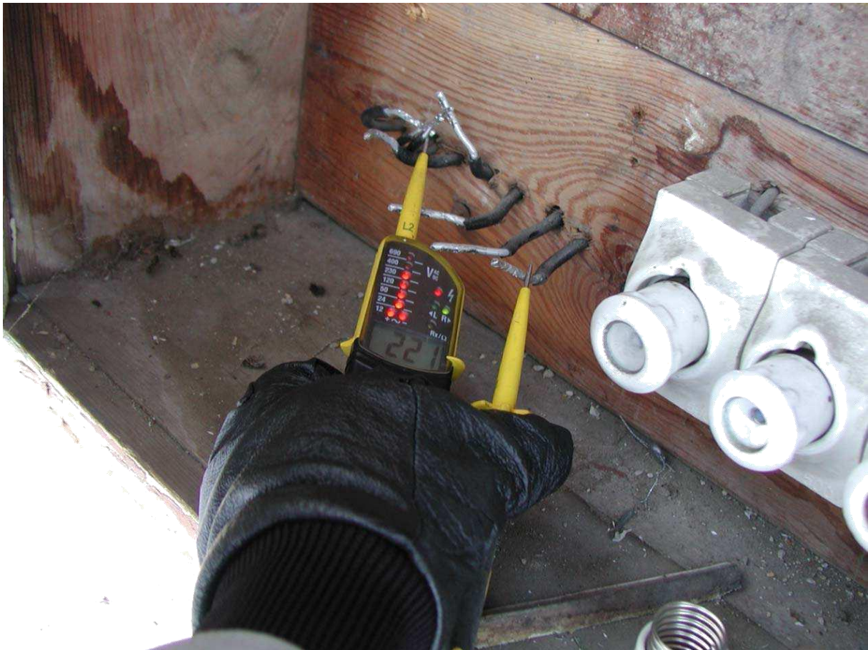
Obr. 32 Napojení 1 fáze bez elektroměru
