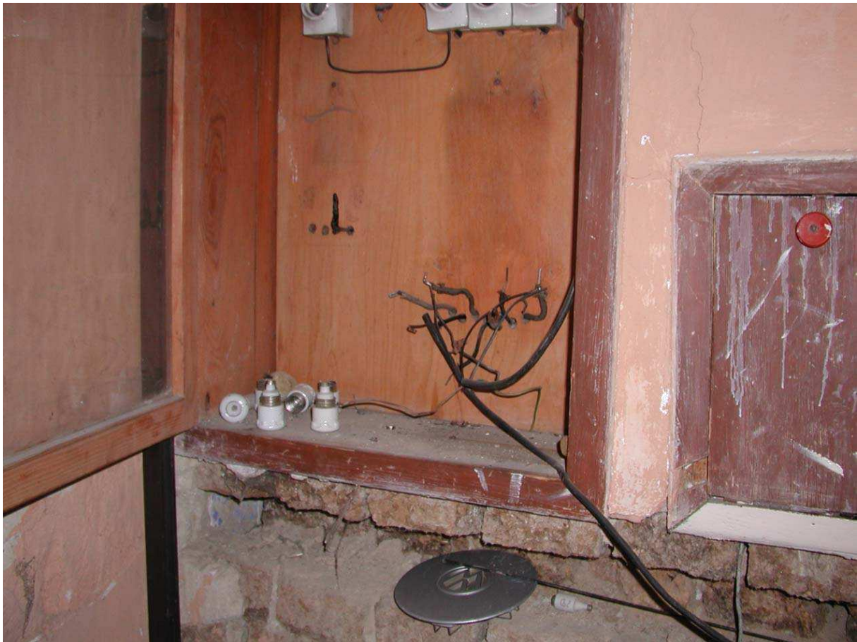
Obr. 28 Napojení odběru elektrické energie bez měření
