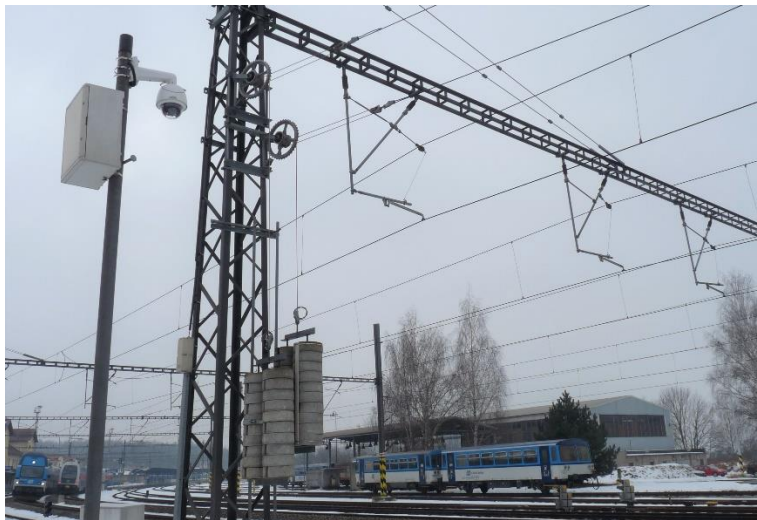
Obrázek 9 - Řetězovkové vedení se závažím
