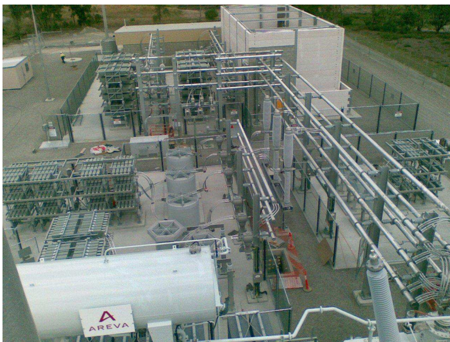
Obr. 2.19 – Systém SVC od Siemensu realizovaný v Austrálii, South East Queensland [12]
