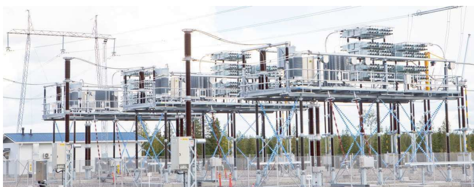
Obr. 2.16 – Pevná sériová kompenzace ABB realizovaná ve Finsku [11]
