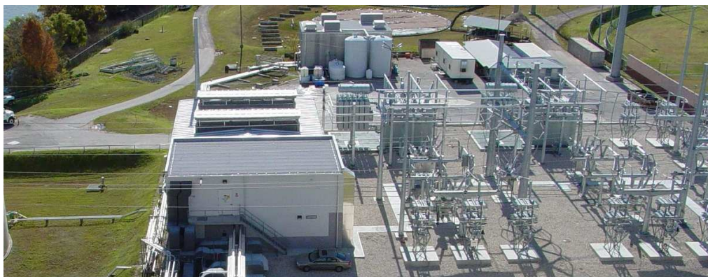
Obr. 1.7 – Systém SVC Light realizovaný v USA, Texas [11]
