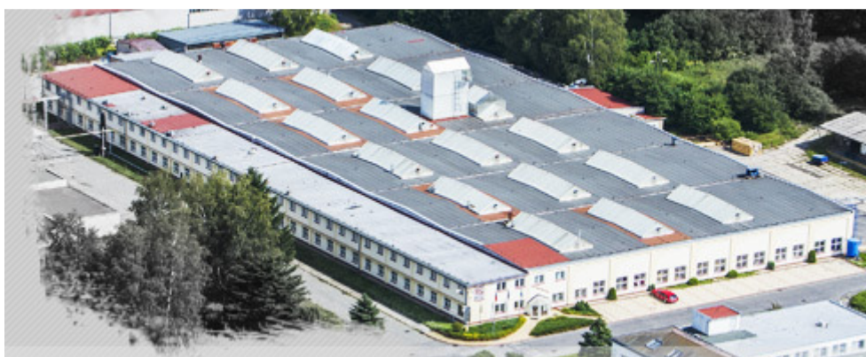
Obr. 10: Firma Backer Elektro CZ, letecký pohled na výrobní halu [6]
