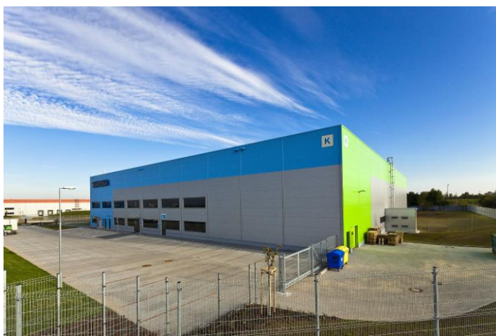
Obrázek 13 Oblast Lehké obvodové pláště Skanska a.s.
