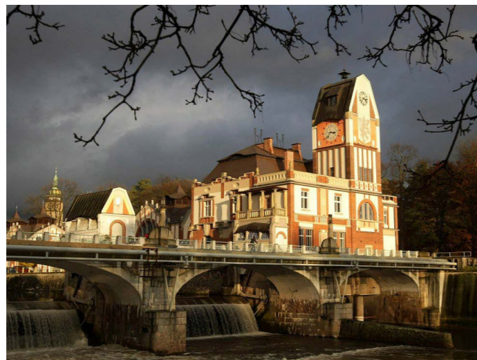
_Malá vodní elektrárna Hučák
