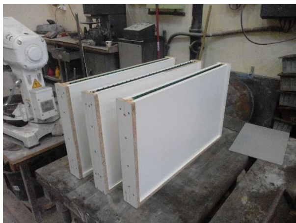
Obrázek 69- Připravené formy na betonáž. [64]
