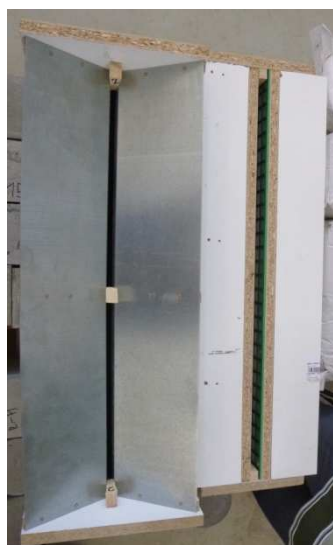
Obrázek 70- Bednění desek shora. [65]
