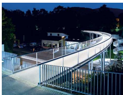
Obrázek 59 Textilbeton, vrchní pohled na most v Lautingen. [55]
