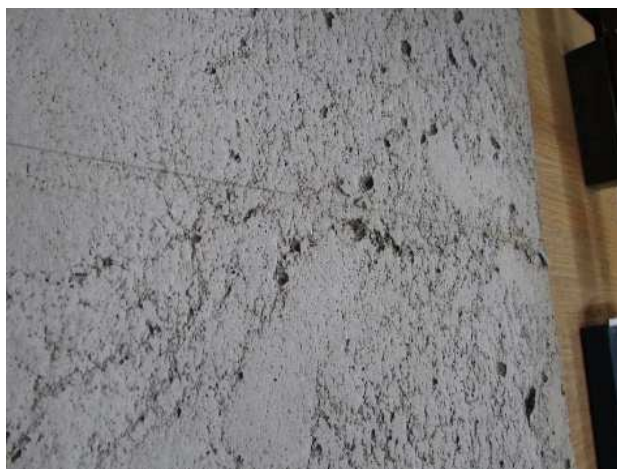
Obrázek 98- Viditelné podrcení betonu v místě zatížení, D1a po zkoušce, tříbodový ohyb. [68]
