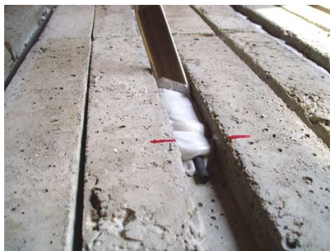
Obrázek 42- Dodatečné vyztužení konstrukce pomocí uhlíkových tyčí. [45]
