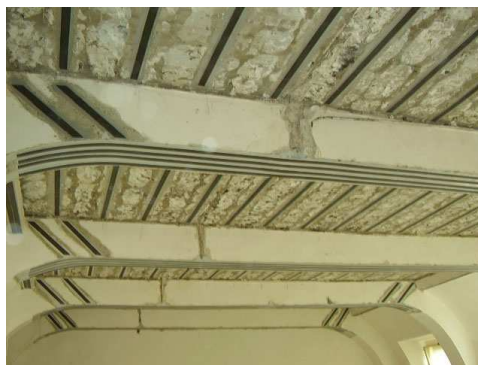
Obrázek 41- Dodatečné vyztužení konstrukce pomocí uhlíkových lamel. [45]
