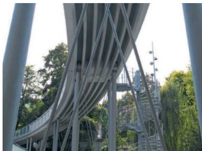
Obrázek 57-Textilbeton, pohled zespodu na most v Lautingen. [54]
