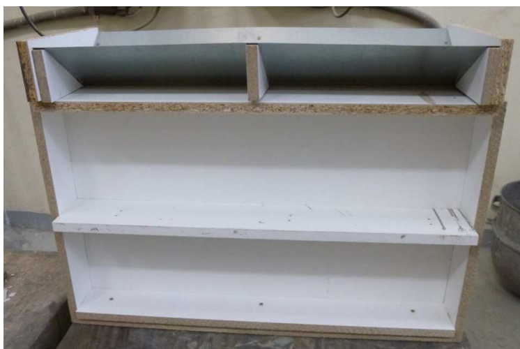
Obrázek 71- Bednění desek z boku. [65]
