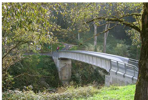
Obrázek 55-Textilbeton, lávka ve městě Kempten. [53]
