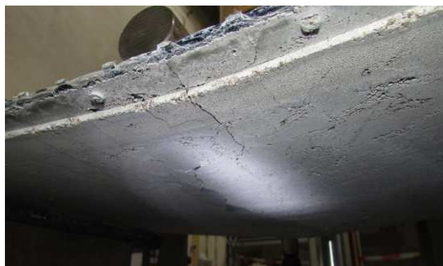
Obrázek 103- Viditelné trhliny na spodní straně desky při zkoušce tříbodovým ohybem, D1b. [68]
