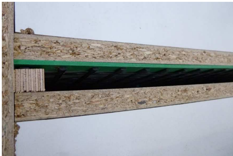
Obrázek 72- Pohled do bednění desek, zelená část je lišta po okraji zajišťující správnou polohu výztuže. [68]
