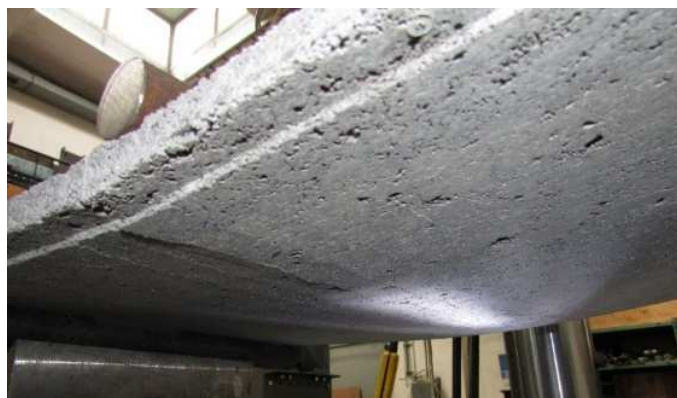
Obrázek 97- Výrazná trhlina v polovině rozpětí při zkoušce tříbodovým ohybem, D1a. [68]
