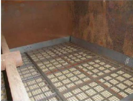
Obrázek 10 – Katalyzátor pro metodu Low-Dust Zdroj [13]
