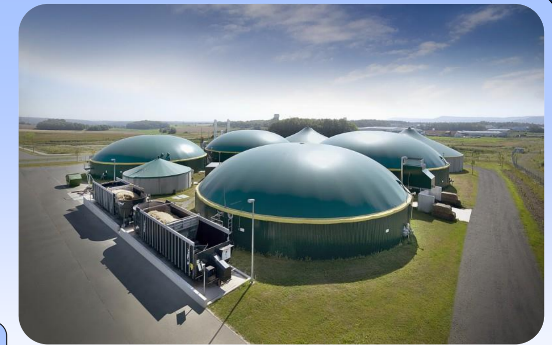
BPS Karlovice ZAS Úžice
