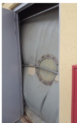
Obrázek 14 – Plynojem nad hlavním fermentorem
