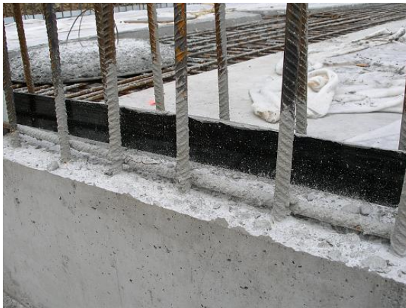
Obrázek 3: bitumenový pás, ukázka z praxe
