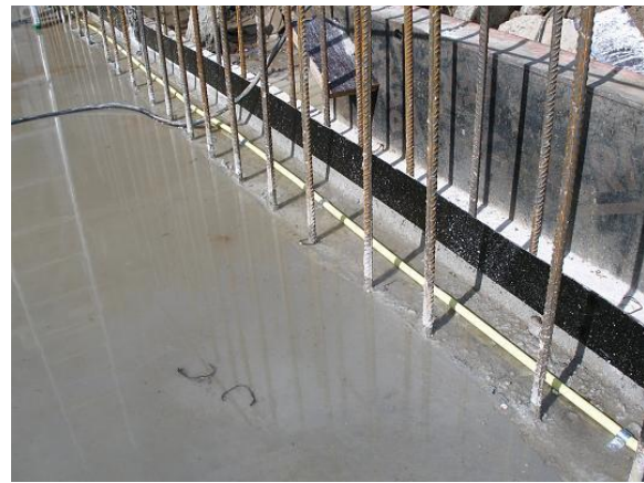
Obrázek 4: bitumenový pás, ukázka z praxe 2
