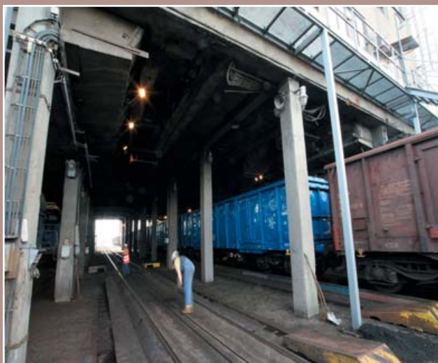
Nakládací koleje - Doly Bílina, Úpravna uhlí Ledvice
