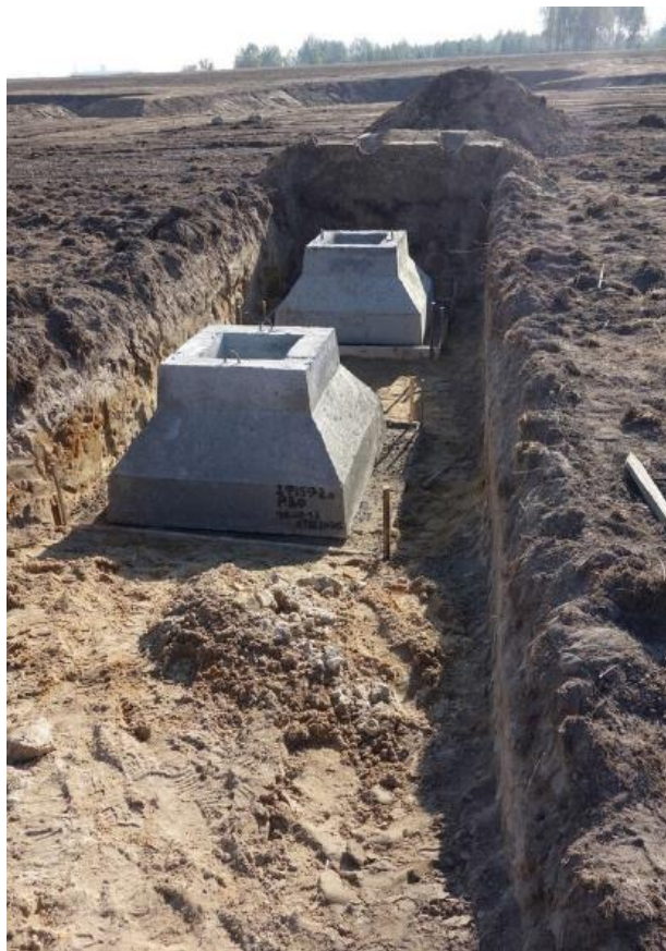
Obrázek 24. Montáž deskových základů pro podpěry dvoukolejné trasy Skyway
