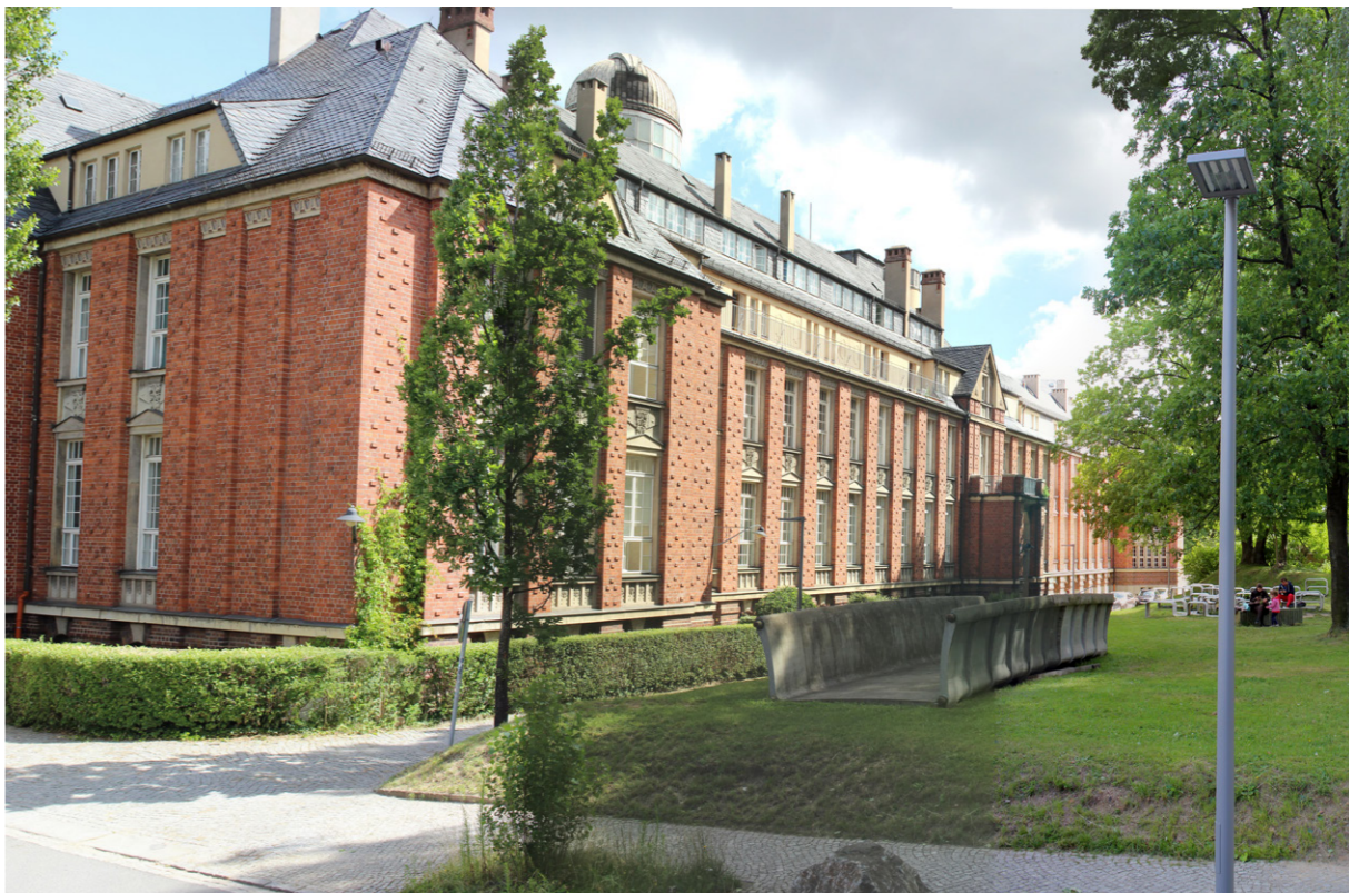
STAVEBNÍ FAKULTA (BEYER BAU)
