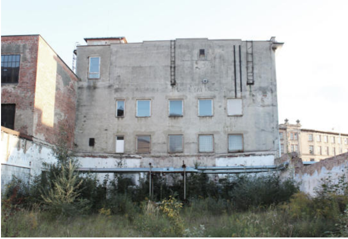
střecha haly č. II, v pozadí zámek
