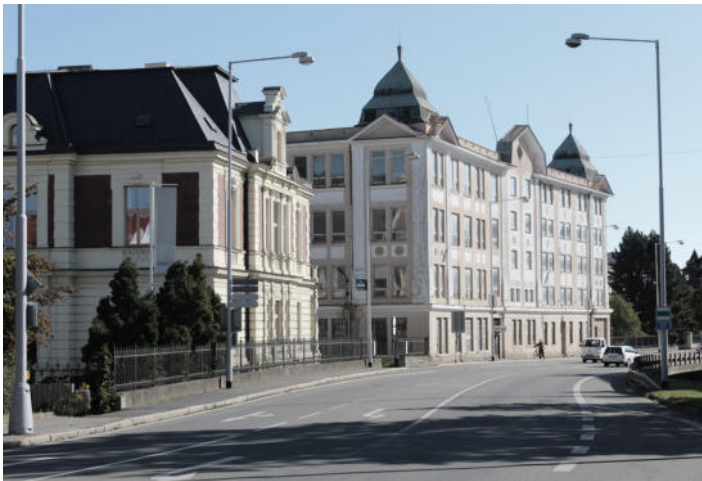
octárna, střední trakt původní tovární budovy, kotelna
