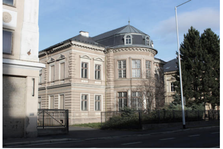
kotelna, západní křídlo původní tovární budovy, hala č. I
