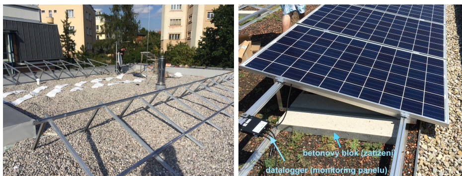
Obrázek 2.7: Technické provedení konstrukce FVE na plochou střechu
