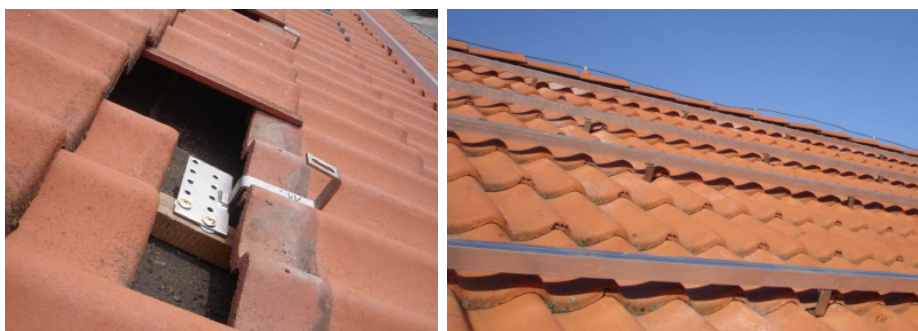
Obrázek 2.5: Technické provedení konstrukce FVE na šikmou střechu
