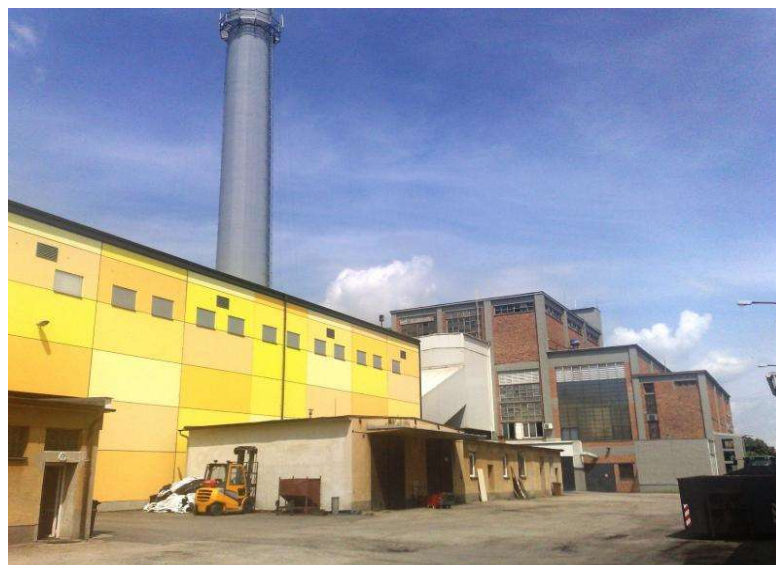
Obrázek 10 Energetické centrum Jindřichův Hradec [11]
