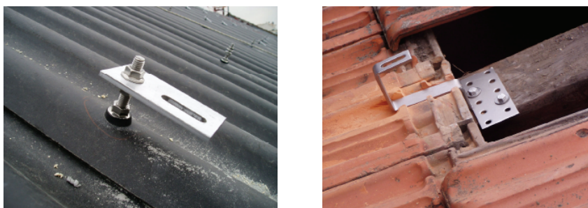
Obrázek 2.1: Možné varianty uchycení panelů na sedlové střechě [1]
