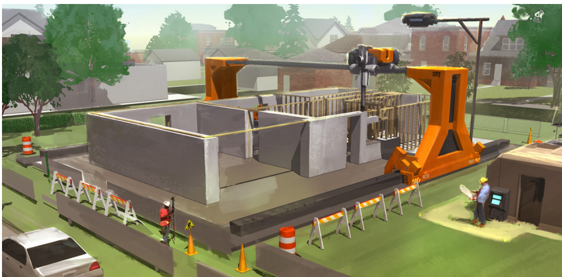
Obr. 11. : Vizualizácia rámovej konštrukcie tlačiarne firmy Caterpillar.
