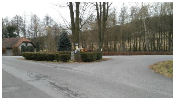
Obrázek 3 - Ostrůvek rozdělující silnici III/1082 a II/335
