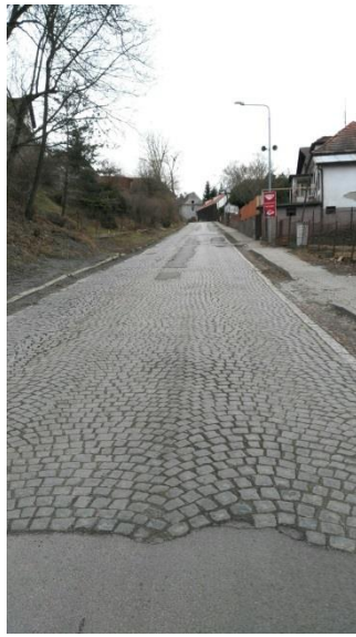
Obrázek 5 – Změna krytu vozovky
