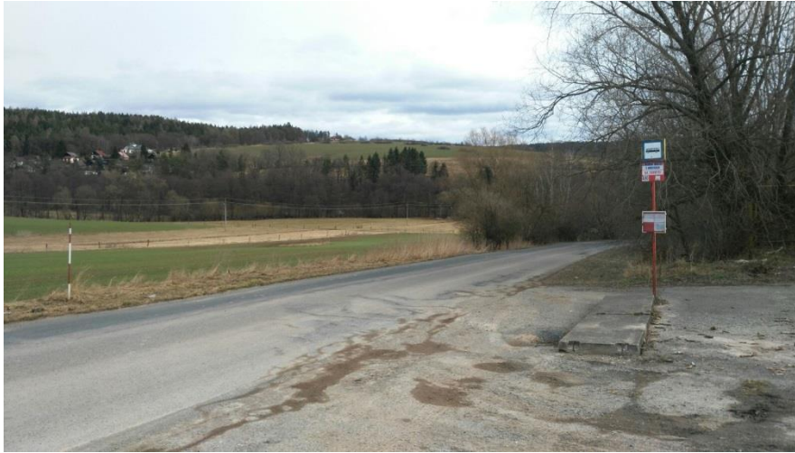
Obrázek 1 - Začátek úseku ve směru staničení (Autobusová zastávka směr Stříbrná Skalice)
