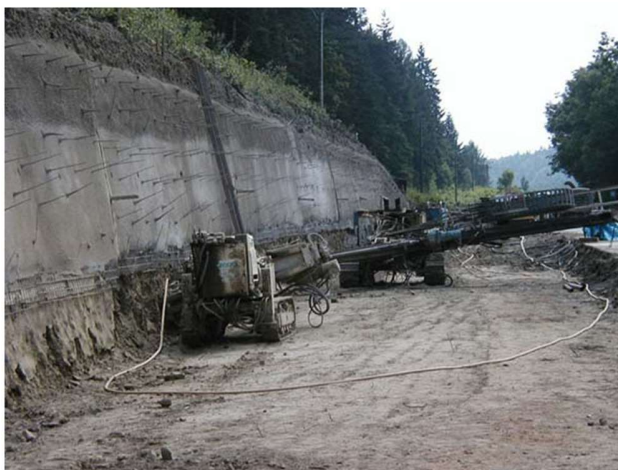
Obr. 6 Práce na hřebíkováném svahu
