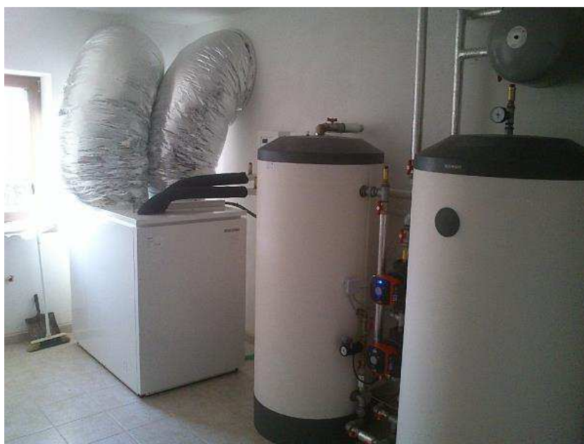
Obr. 3: foto instalovaná vnitřní jednotka tepelného čerpadla [11]
