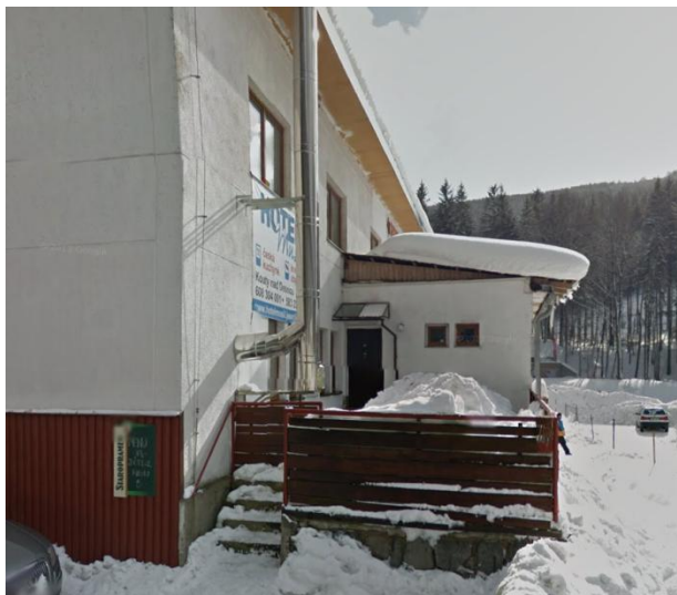
Obr. 3: Administrativní zázemí stavby (Převzato z [16 ])
