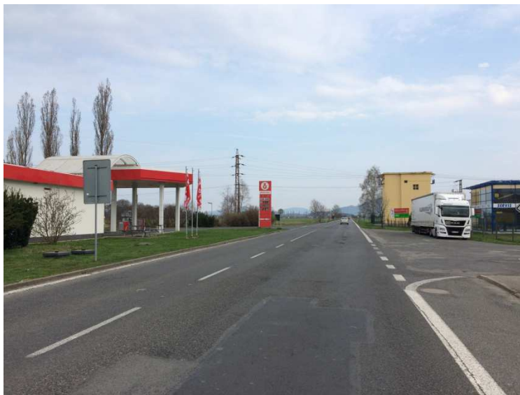
Obrázek 32 Pohled (směr Jablonné v Podještědí) na křížení, které bude za žlutou trafo stanicí
