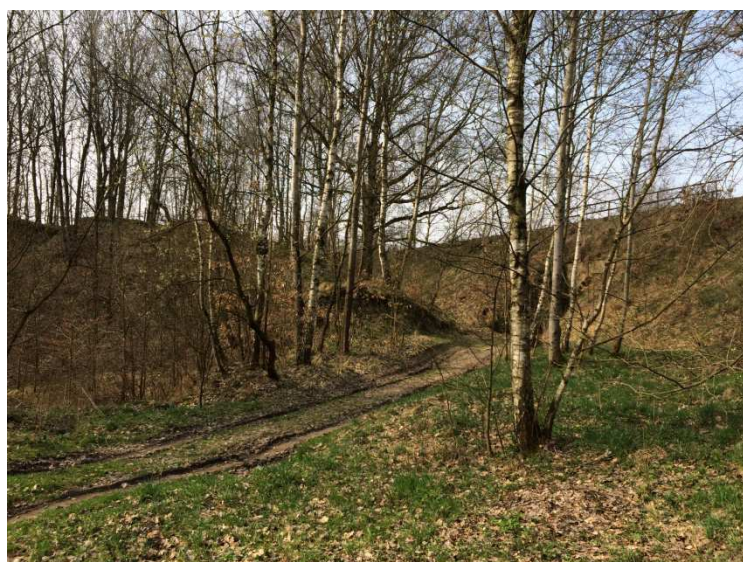
Obrázek 24 Pohled na násep železnice z druhé strany
