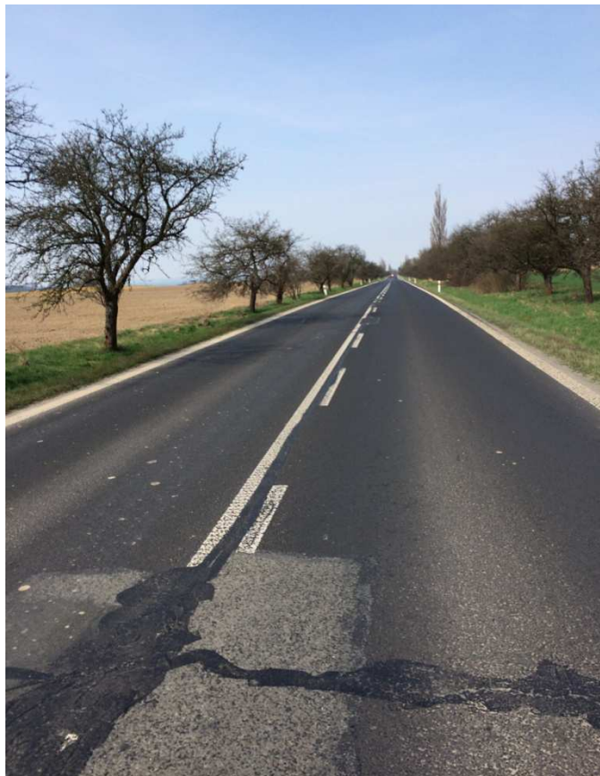
Obrázek 18 Pohled na komunikaci II/268 směrem na Českou Lípu, křížení je cca 10m od místa fotky, vyhýbám se schválně zářezu viz další fotka
