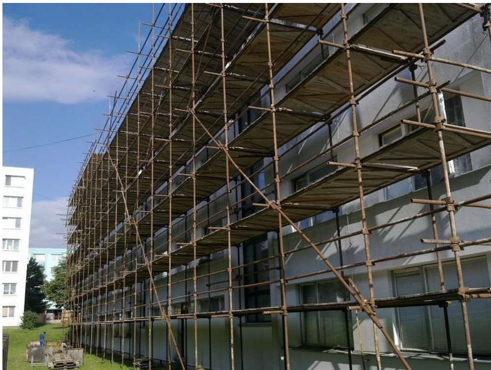
Obrázek 1 - Příklad realizovaného trubkového lešení
