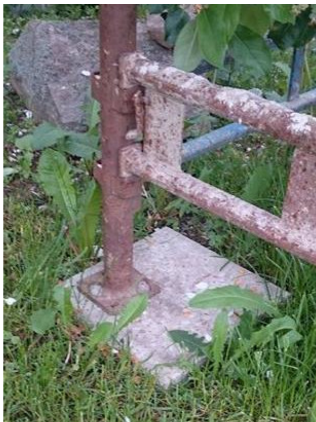
Obrázek 22 - Excentricky založení haki lešení na betonové dlaždici
