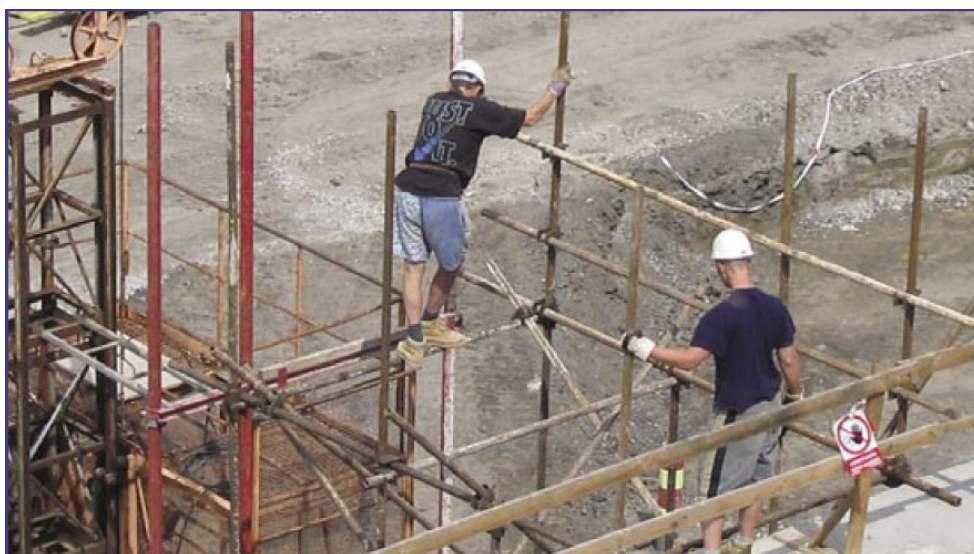
Obrázek 19 - Příklad nedodržení bezpečnosti
