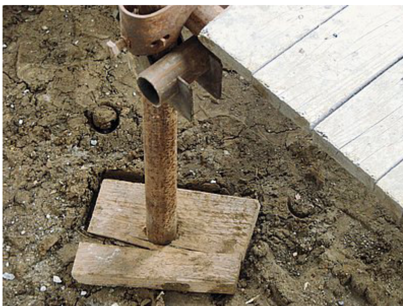
Obrázek 24 - Nestabilní založení trubkového lešení bez nánožky
