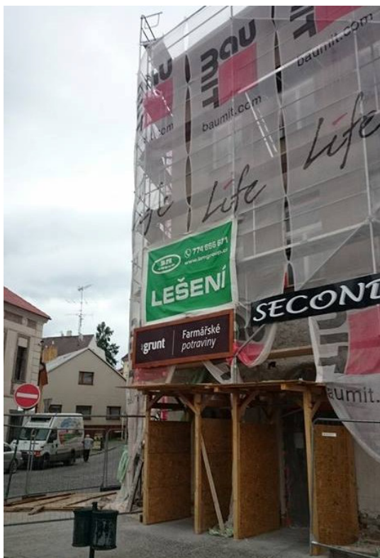
Obrázek 5 - Realizace rámového lešení
