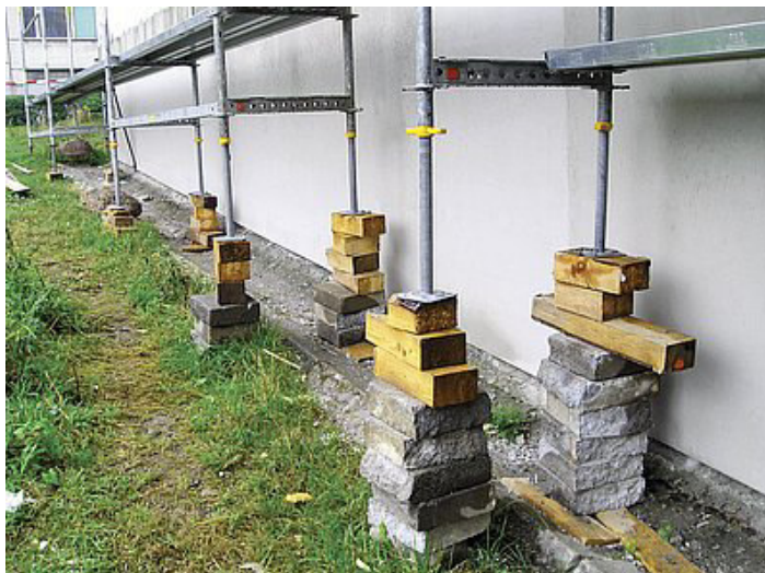
Obrázek 23 - Nevyužití nánožek, nestabilní založení
