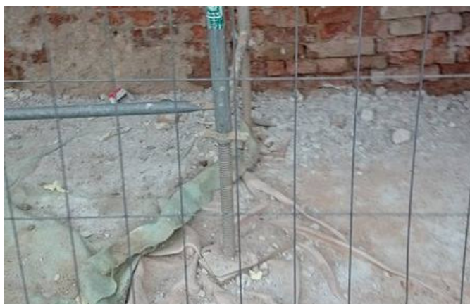
Obrázek 28 - Šroubová patka rámového lešení
