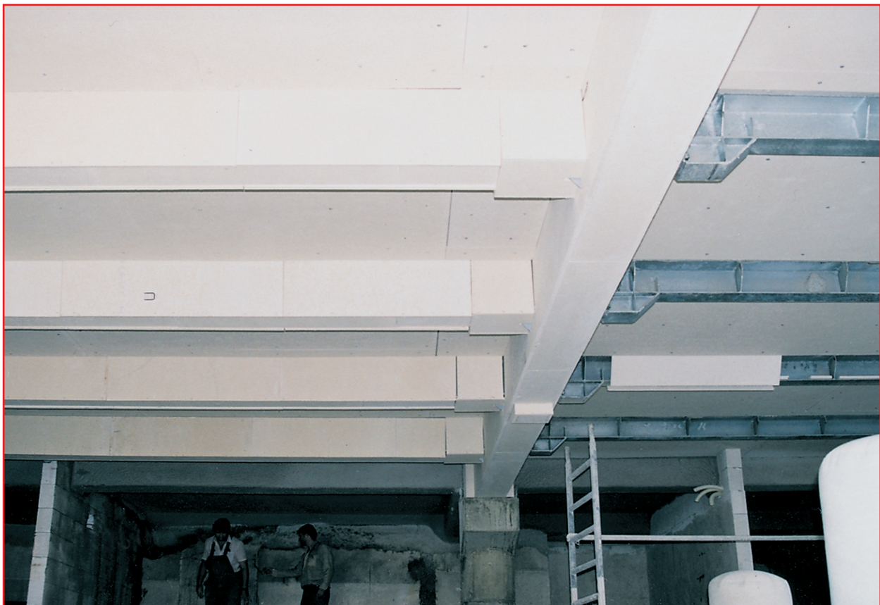
Obklad ocelových konstrukcí požárně ochrannými deskami PROMATECT®
