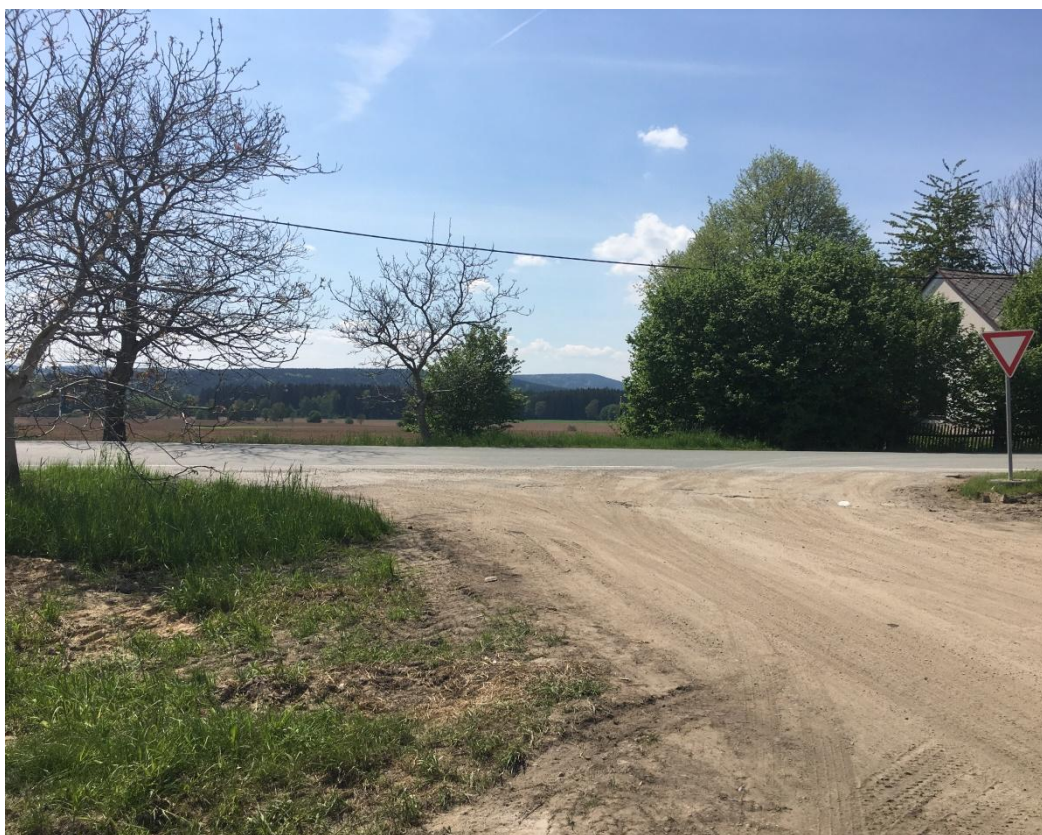
Obr.8 – napojení účelové komunikace na silnici III/3036 (pohled z účelové komunikace)
