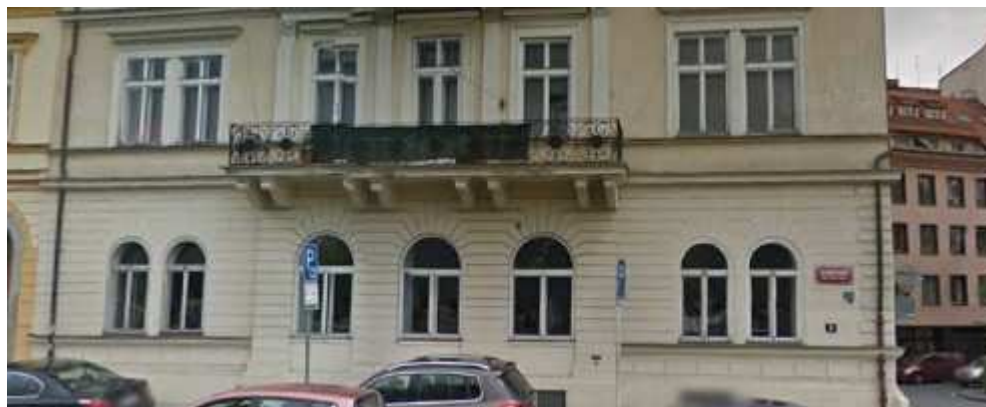
Obr. 30 Pohled na západní fasádu
