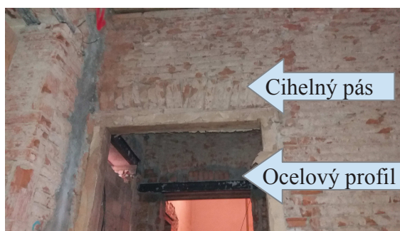
Obr. 21 Nadpraží otvorů v II. NP
