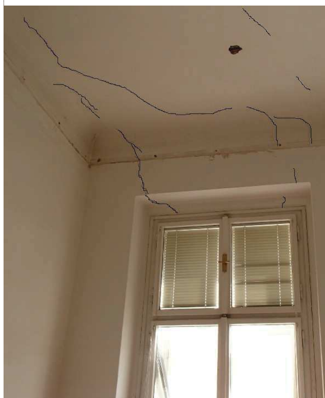
Obr. 53 Přejít trhlín z klenob do svislých keří
