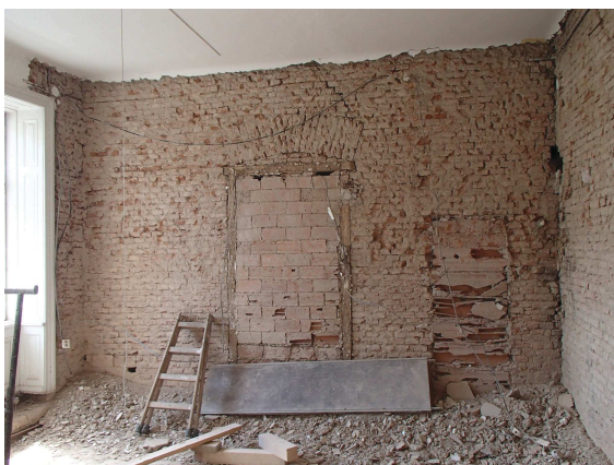
Obr. 8 Zdivo II. NP – zazděné otvory
