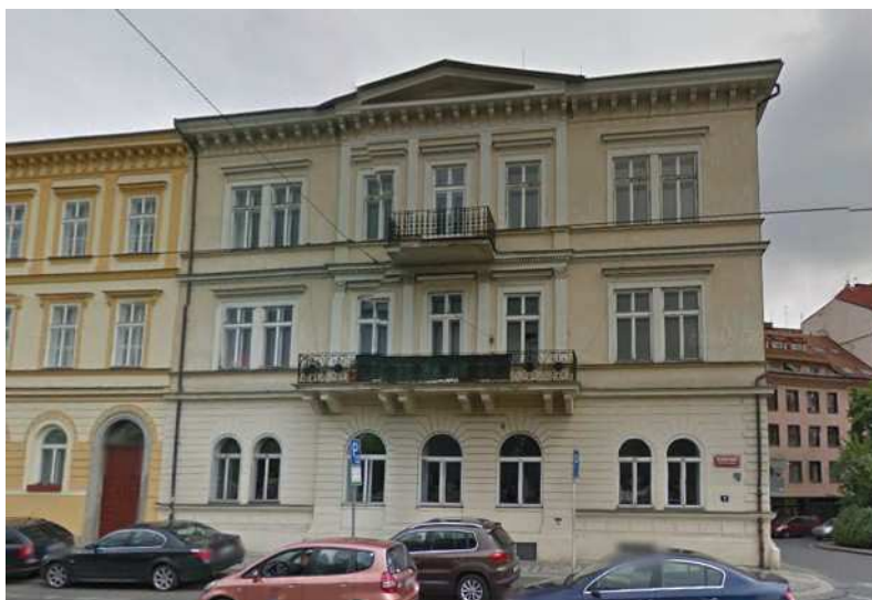
Obr. 2 Pohled na západní fasádu
