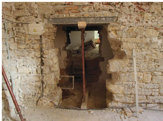
Obr. 19 Nadpraží tvořené ocelovým profilem
