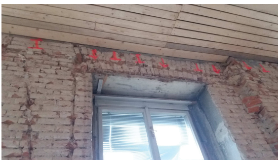
Obr. 20 Nadpraží tvořené dřevěnou fošnou
