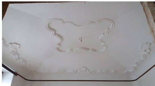
Obr. 15 Strop na místností č. 1.04 - zrcadlová klenba
