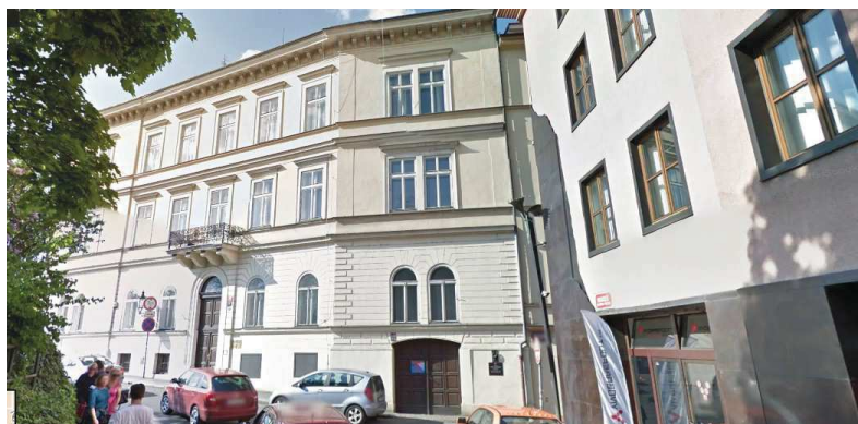
Obr. 4 Pohled na jižní fasádu
