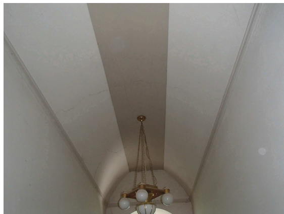
Obr. 13 Strop nad místností číslo 1.01 - zrcadlová klenba
