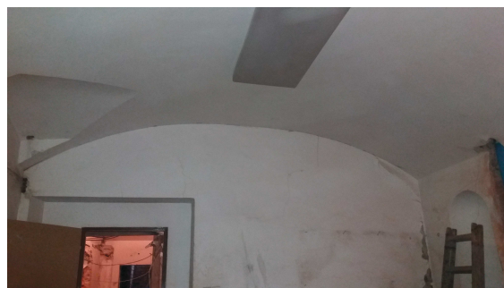
Obr. 11 Strop nad místností č. 0.10 - valená segmentová klenba
