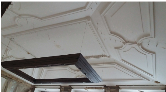
Obr. 14 Strop nad místností č. 1.05 - zrcadlová klenba
