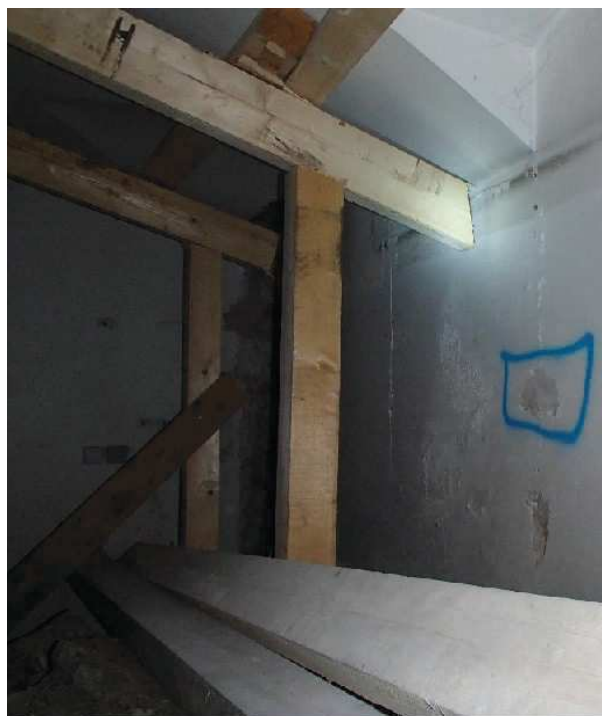
Obr. 41 Vlhkost na zdech v suterénu
