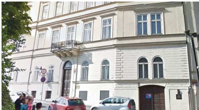
Obr. 31 Pohled na jižní fasádu
