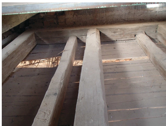
Obr. 18 Podlaha III. NP - trámový strop s rákosníky
