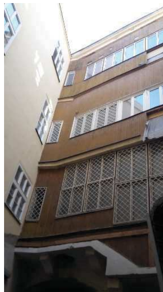
Obr. 33 Pohled na severní fasádu
