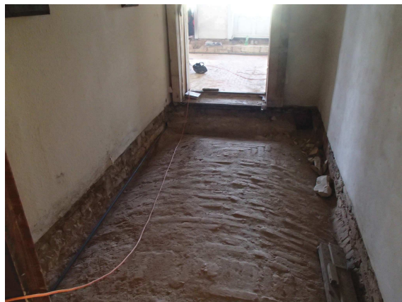
Obr. 27 Nosná konstrukce podlahy v II. NP
