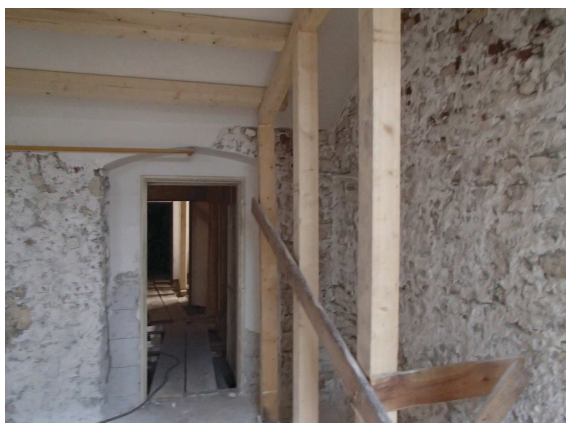
Obr. 12 Strop nad místností č. 0.08 - valená segmentová klenba
