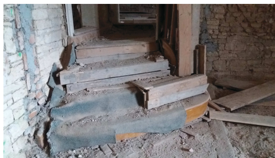
Obr. 23 Schodiště v místnosti č. 1.08
