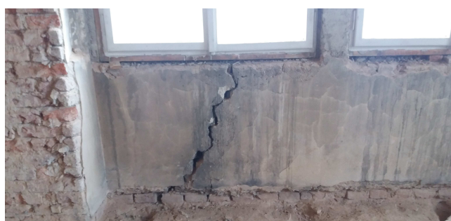
Obr. 51 Svislé trhliny procházející římsou
