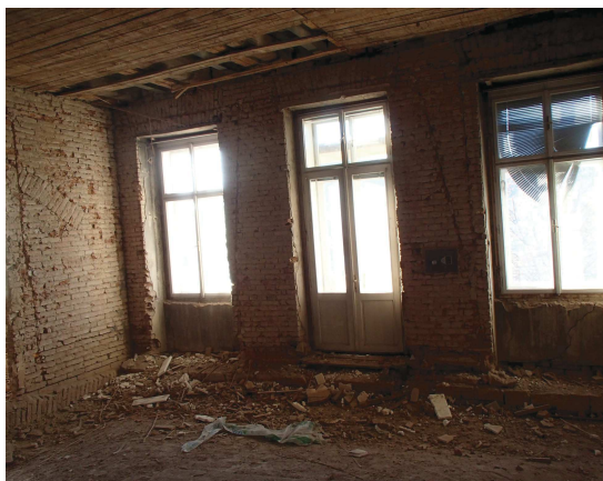
Obr. 28 Výplně otvorů v místnosti č. 2.08
