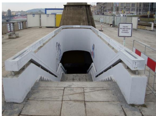
Obr. 42 – Bariérový vstup do podchodu 4
