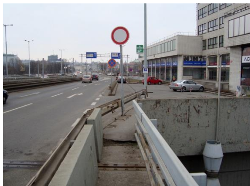
Obr. 65 – Parkoviště před budovou
