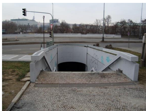
Obr. 44 – Bariérový vstup do podchodu 5
