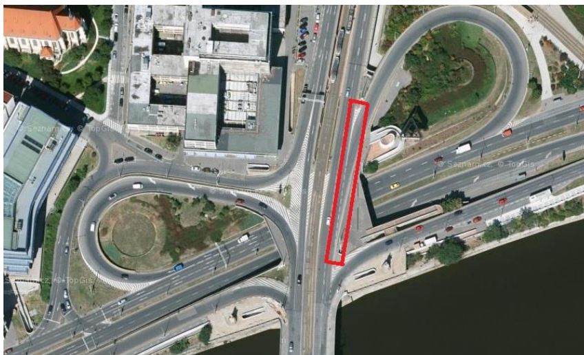
Obr. 77 – Letecký pohled s vyznačeným místem určeným pro betonová svodidla, zdroj [18]
