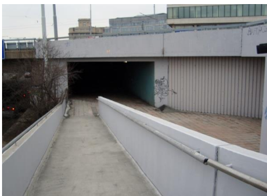
Obr. 37 – Bezbariérový vstup do podchodu 1
