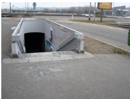
Obr. 53 – Vstup do podchodu 1
