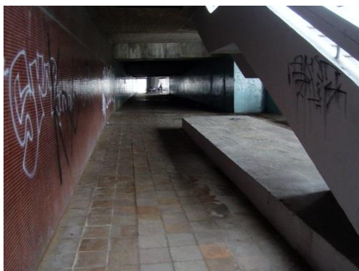
Obr. 41 – Bezbariérový podchod pod SJM
