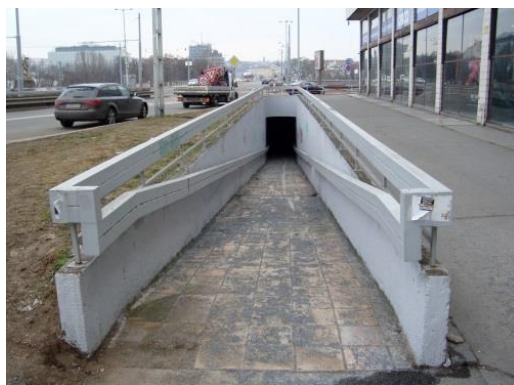
Obr. 36 – Bezbariérový vstup do podchodu 1
