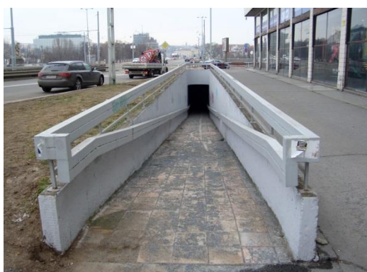
Obr. 55 – Vstup do podchodu 1
