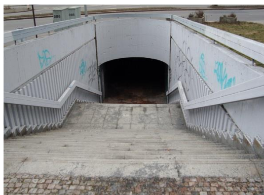
Obr. 54 – Vstup do podchodu 5
