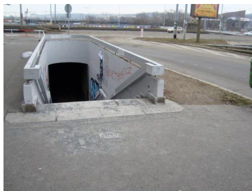
Obr. 38 – Bariérový vstup do podchodu 1
