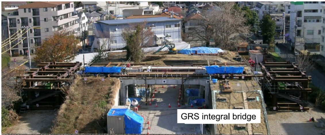
Obrázek 31 – Pohled na laboratorní model mostu. [8]
