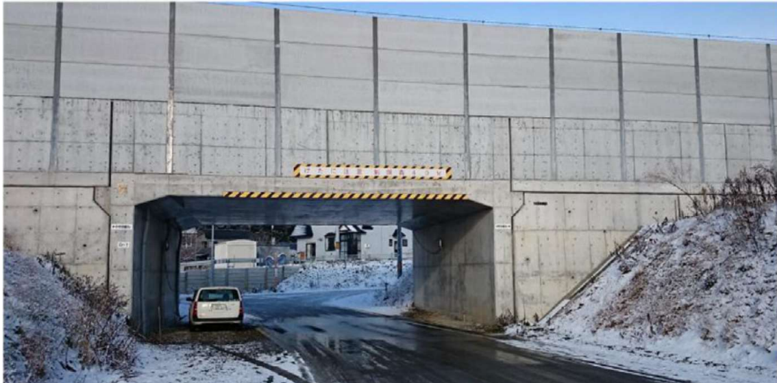
Obrázek 34 – Pohled na GRS integral bridge u Kikonai po dokončení. [8]
