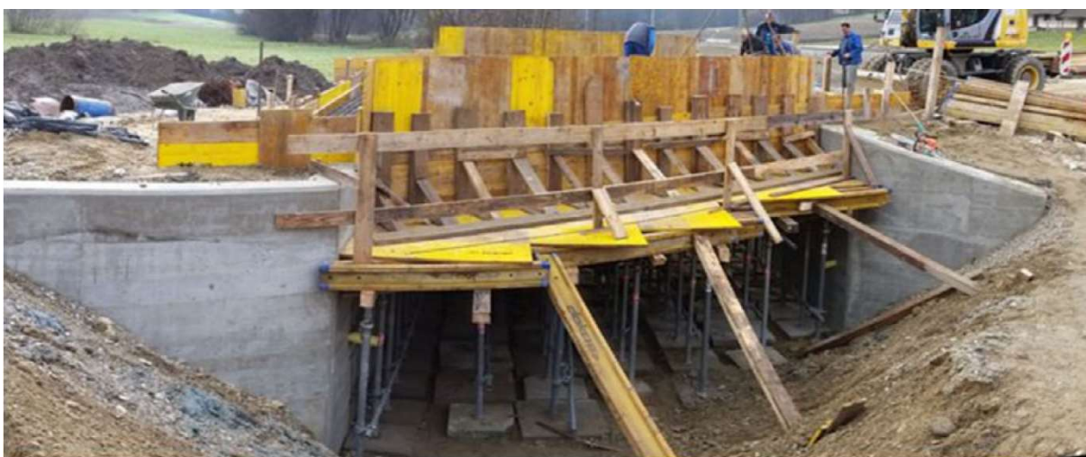
Obrázek 42 – Výstavba Žerovínckého mostu. [16]
