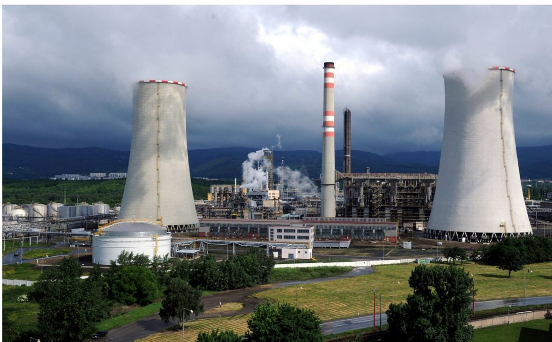
Obr. 8: Pohled na chladičí věže Unipetrol Litvínov (převzato z (Unipetrol slibuje světlé zítřky. Neříká však, co s problémovou Spolanou))
