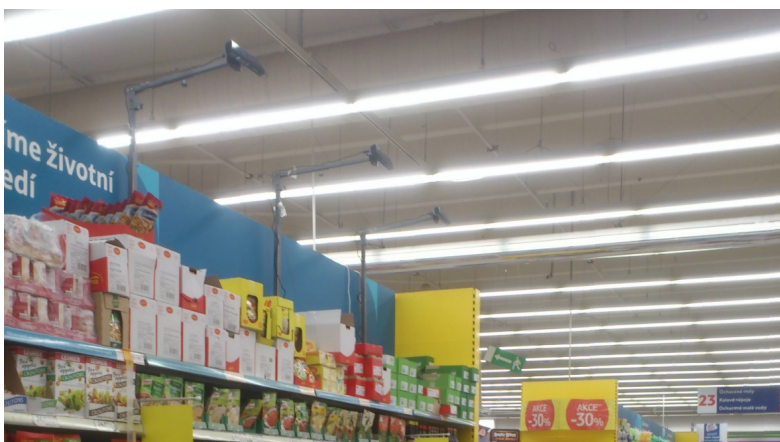
Obrázek 1.1: Zařízení instalovaná v obchodním domě
