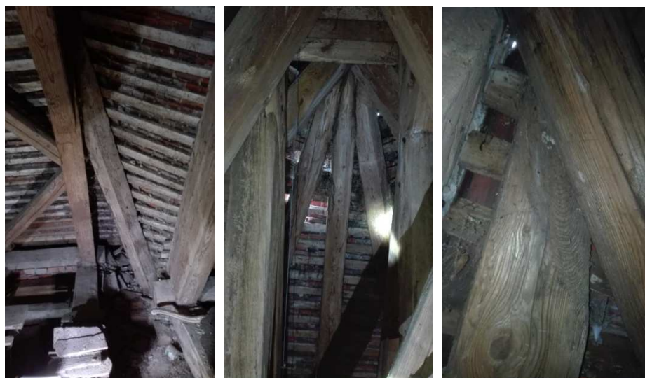
Obr. č. 29, 30 a 31 přechodová krokev mezi hl. lodí a presbytářem, napojení tří čelních krokví valby, lípnutí krokve na krokev v rohu u věže
