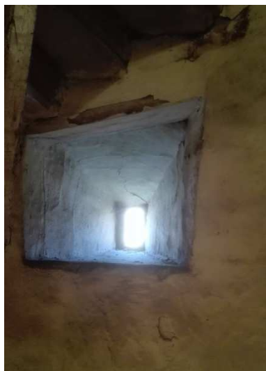
Obr. č. 16 a 17 okno nad schody do zvonice, staré odříznuté zhlaví trámů
