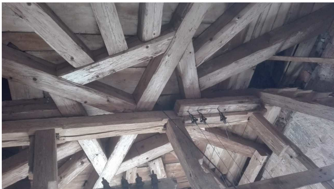
Obr. 23 rošt z vazných trámů tvořící strop 3. patra zvonice vpravo patrné schodiště do krovu
