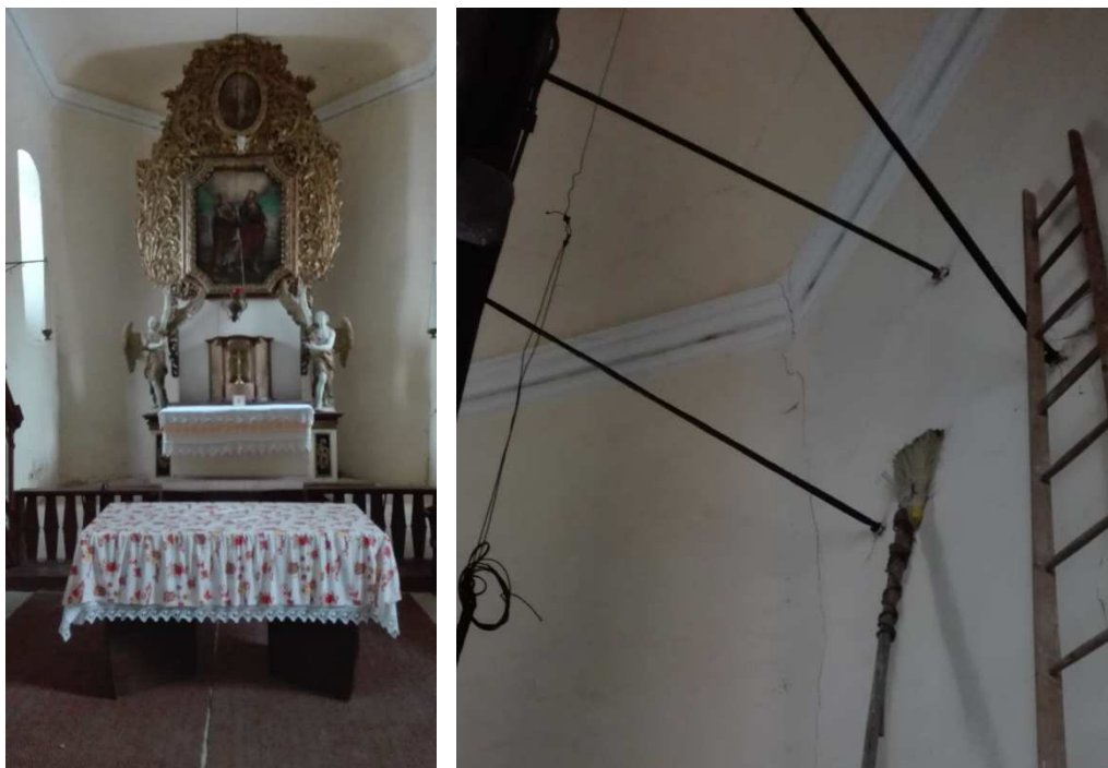
Obr. č. 10 a 11 hl. oltář kostela s obrazem sv. Petra a Pavla, kotvení ocelovými táhy
