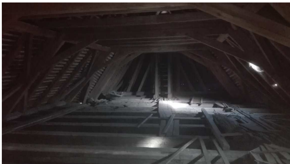
Obr. č. 28 pohled do krovu
