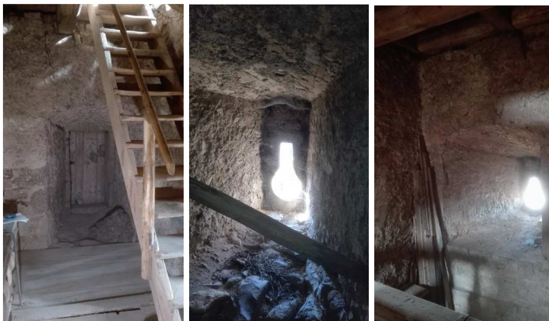
Obr. 18, 19 a 20 pohled na vstup do krovu kostela a žebř. schodiště do věže, jižní střílna, prostor nad schodištěm se severní střílnou.
