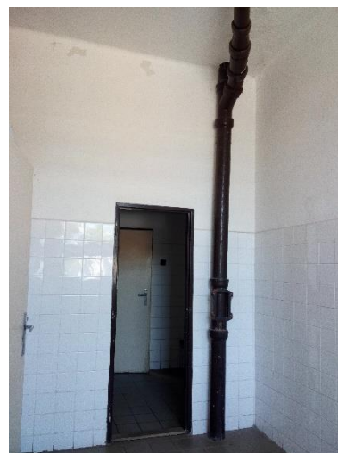
obr. 45 – Dodatečně provedená kanalizace v budově školy [zdroj vlastní]
