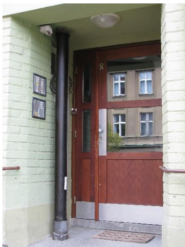
obr. 44 – Dodatečně provedená kanalizace v bytovém domě [zdroj vlastní]
